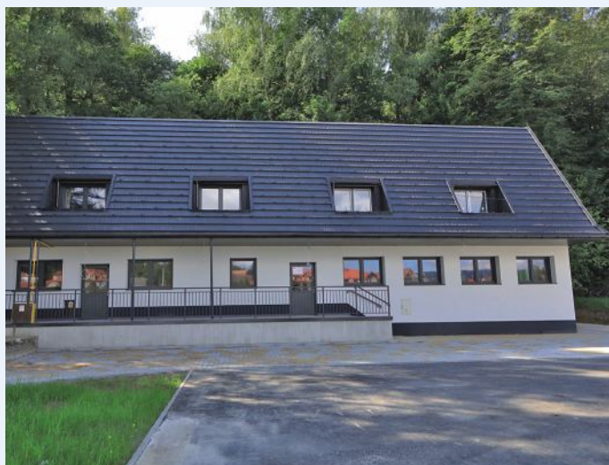
4. Modernizacja budynku zaplecza na stadionie – całkowita wartość projektu 211.377,79 zł , w tym dofinansowanie 120.186,00 zł .
