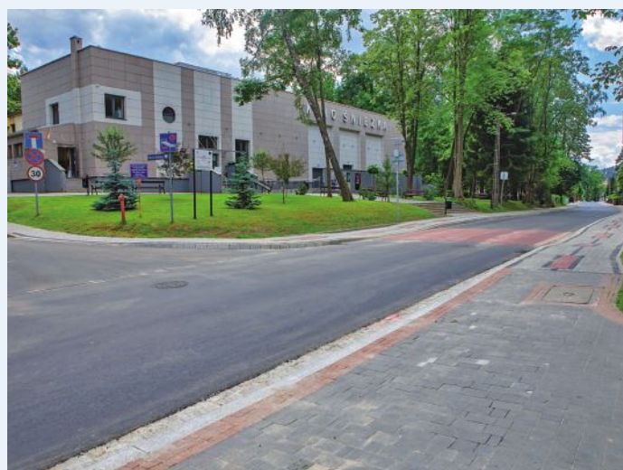
9. Przebudowa ul. Nowy Świat w Rabce-Zdroju – całkowita wartość zadania 1.526.988,35 zł , w tym dofinansowanie 1.002.337,00 zł.
