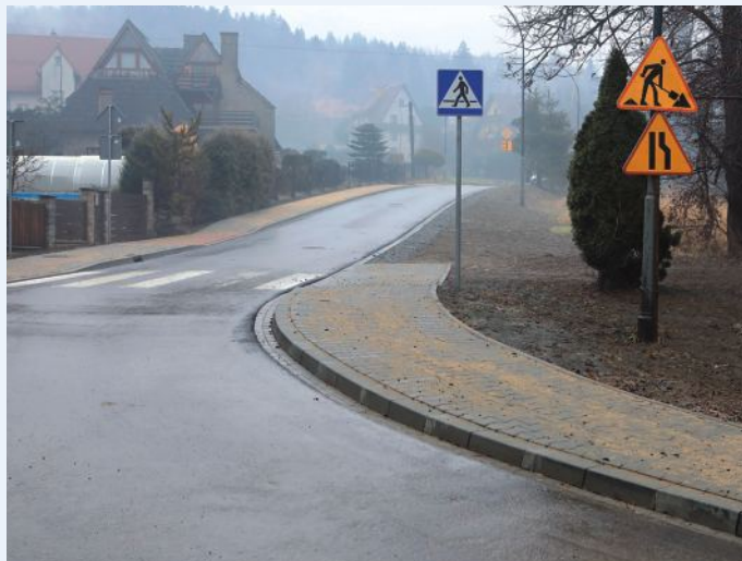
2. Przebudowa ul. Traczykówka – całkowita wartość zadania 1.076.509,08 zł , w tym dofinansowanie w wysokości 410.111,00 zł .
