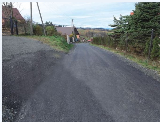
10. Przebudowa drogi do osiedla Litwinówka w Rdzawce – wartość zadania 52.210,28 zł.
