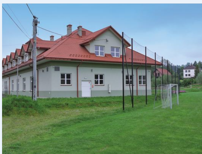
12. Zabezpieczenie zaplecza dla Klubu Sportowego w Chabówce – wartość zadania 79.259,66 zł.
