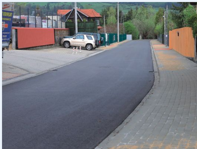
8. Przebudowa ul. Kasprowicza w Rabce-Zdroju – całkowita wartość zadania 2.025.876,40 zł , w tym dofinansowanie 1.382.918,00 zł.
