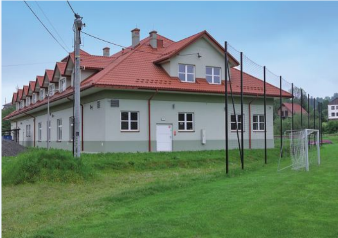
6. Wykonanie pomieszczeń zaplecza dla Klubu Sportowego w Chabówce. Wykonanie: 49.984,14 zł.
