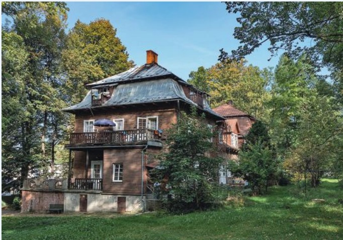
8. Wykonania prac konserwatorskich w zabytkowym budynku Willa Liliana. Wykonanie: 137.670,52 zł. Zadanie zrealizowano przy współfinansowaniu ze środków Wojewódzkiego Konserwatora Zabytków w wysokości 57.333,12 zł.
