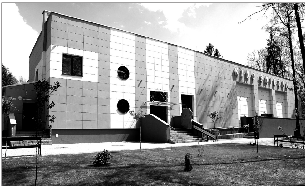
Budynek kina „Śnieżka” po remoncie w 2015 r. Fot. P. Kuczaj
