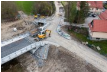
• 2022-05-02-Postępy prac na budowie mostu nad Poniczanką
