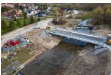
• 2022-05-02-Postępy prac na budowie mostu nad Poniczanką
