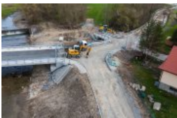
• 2022-05-02-Postępy prac na budowie mostu nad Poniczanką
