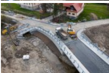
• 2022-05-02-Postępy prac na budowie mostu nad Poniczanką
