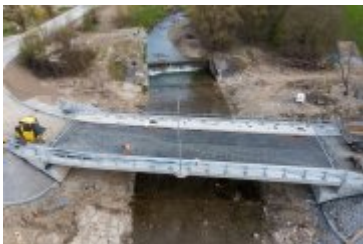
• 2022-05-02-Postępy prac na budowie mostu nad Poniczanką
