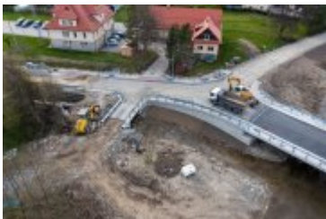
• 2022-05-02-Postępy prac na budowie mostu nad Poniczanką
