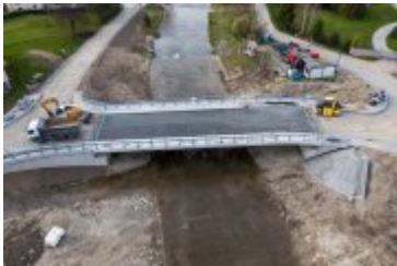
• 2022-05-02-Postępy prac na budowie mostu nad Poniczanką
