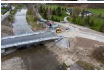
• 2022-05-02-Postępy prac na budowie mostu nad Poniczanką
