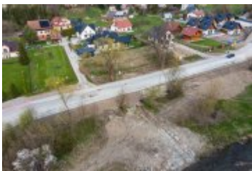
• 2022-05-02-Postępy prac na budowie mostu nad Poniczanką
