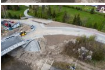
• 2022-05-02-Postępy prac na budowie mostu nad Poniczanką
