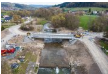
• 2022-05-02-Postępy prac na budowie mostu nad Poniczanką
