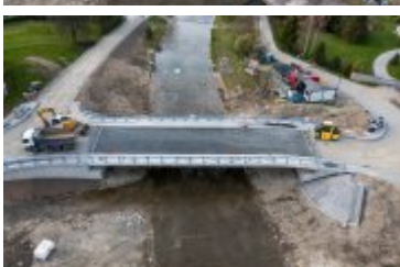
• 2022-05-02-Postępy prac na budowie mostu nad Poniczanką
