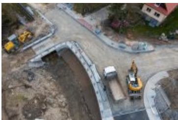
• 2022-05-02-Postępy prac na budowie mostu nad Poniczanką
