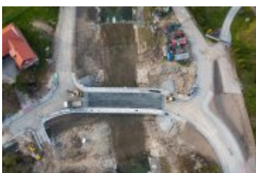
• 2022-05-02-Postępy prac na budowie mostu nad Poniczanką
