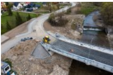
• 2022-05-02-Postępy prac na budowie mostu nad Poniczanką
