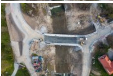
• 2022-05-02-Postępy prac na budowie mostu nad Poniczanką
