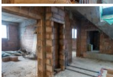
• 2025-02-18- Postępy prac na budowie szpitala
