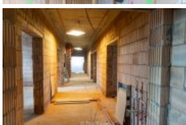
• 2025-02-18- Postępy prac na budowie szpitala
