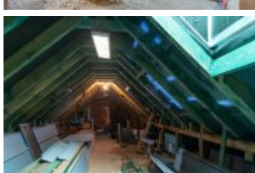
• 2025-02-18- Postępy prac na budowie szpitala
