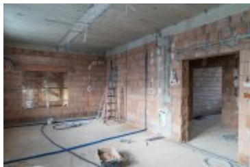
• 2025-02-18- Postępy prac na budowie szpitala
