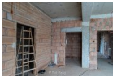
• 2025-02-18- Postępy prac na budowie szpitala
