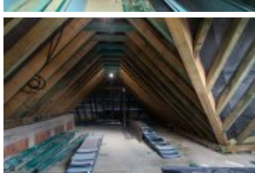
• 2025-02-18- Postępy prac na budowie szpitala
