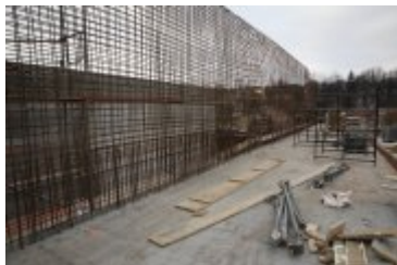
• 2018-02-21-Budowa nowego budynku Teatru Lalek Rabcio
