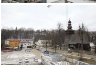
• 2018-02-21-Budowa nowego budynku Teatru Lalek Rabcio
