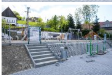
• 2021-06-04-Budowa placu zabaw w Rdzawce
