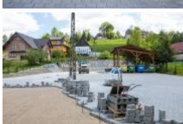
• 2021-06-04-Budowa placu zabaw w Rdzawce
