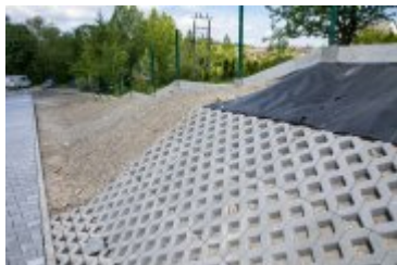
• 2021-06-04-Budowa placu zabaw w Rdzawce
