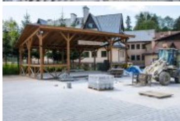
• 2021-06-04-Budowa placu zabaw w Rdzawce
