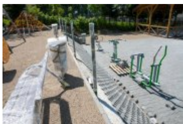
• 2021-06-04-Budowa placu zabaw w Rdzawce
