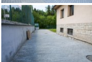
• 2021-06-04-Budowa placu zabaw w Rdzawce
