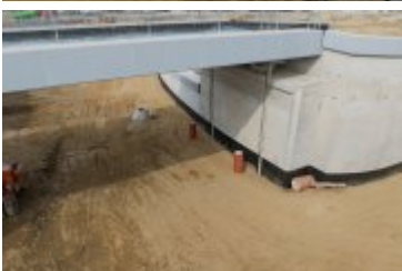
• 2025-03-12- Przebudowa ul. Zakopiańskiej
