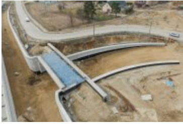
• 2025-03-12- Przebudowa ul. Zakopiańskiej
