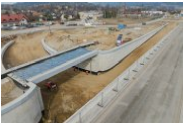
• 2025-03-12- Przebudowa ul. Zakopiańskiej
