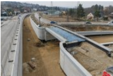
• 2025-03-12- Przebudowa ul. Zakopiańskiej
