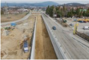
• 2025-03-12- Przebudowa ul. Zakopiańskiej
