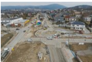
• 2025-03-12- Przebudowa ul. Zakopiańskiej
