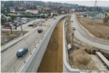
• 2025-03-12- Przebudowa ul. Zakopiańskiej
