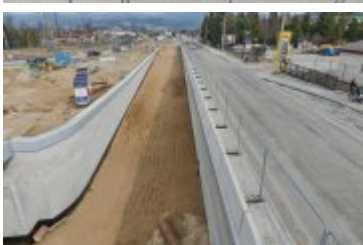
• 2025-03-12- Przebudowa ul. Zakopiańskiej
