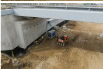
• 2025-03-12- Przebudowa ul. Zakopiańskiej
