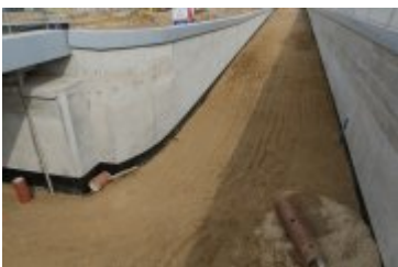
• 2025-03-12- Przebudowa ul. Zakopiańskiej
