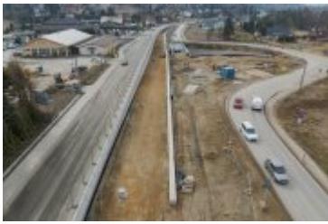
• 2025-03-12- Przebudowa ul. Zakopiańskiej
