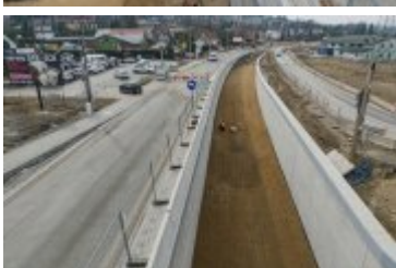
• 2025-03-12- Przebudowa ul. Zakopiańskiej
