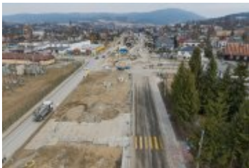
• 2025-03-12- Przebudowa ul. Zakopiańskiej
