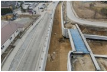
• 2025-03-12- Przebudowa ul. Zakopiańskiej
