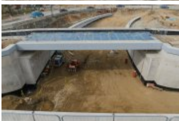
• 2025-03-12- Przebudowa ul. Zakopiańskiej
