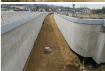
• 2025-03-12- Przebudowa ul. Zakopiańskiej
