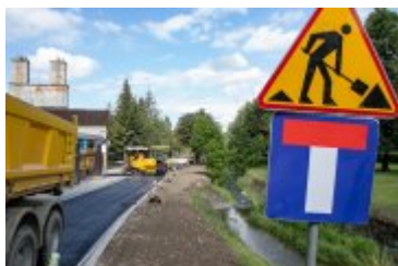
• 2020-08-25-Układanie dywanika asfaltowego na Alei Tysiąclecia
