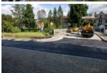
• 2020-08-25-Układanie dywanika asfaltowego na Alei Tysiąclecia
