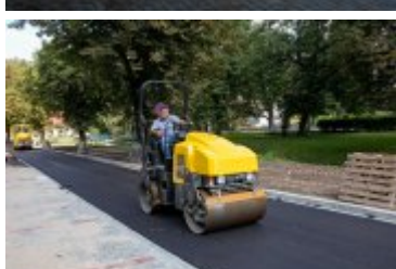
• 2020-08-25-Układanie dywanika asfaltowego na Alei Tysiąclecia
