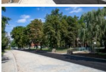
• 2020-08-25-Układanie dywanika asfaltowego na Alei Tysiąclecia
