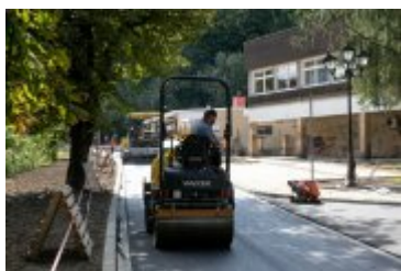
• 2020-08-25-Układanie dywanika asfaltowego na Alei Tysiąclecia
