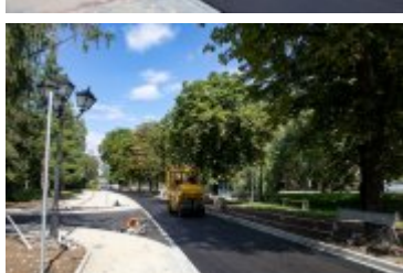
• 2020-08-25-Układanie dywanika asfaltowego na Alei Tysiąclecia
