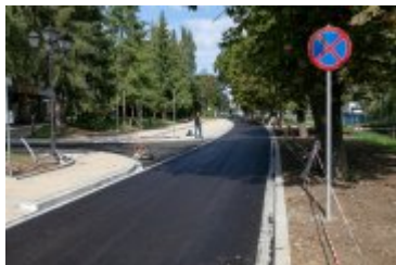
• 2020-08-25-Układanie dywanika asfaltowego na Alei Tysiąclecia
