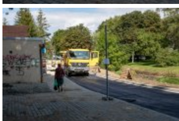
• 2020-08-25-Układanie dywanika asfaltowego na Alei Tysiąclecia
