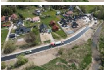
• 2022-05-12-Postępy prac na budowie mostu nad Poniczanką
