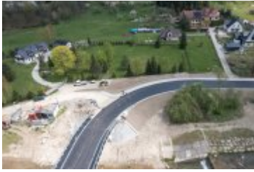
• 2022-05-12-Postępy prac na budowie mostu nad Poniczanką
