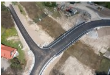
• 2022-05-12-Postępy prac na budowie mostu nad Poniczanką
