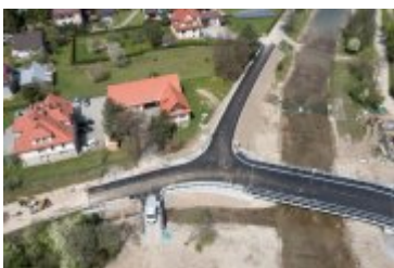
• 2022-05-12-Postępy prac na budowie mostu nad Poniczanką
