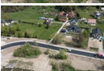
• 2022-05-12-Postępy prac na budowie mostu nad Poniczanką
