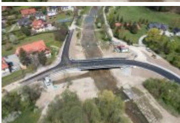
• 2022-05-12-Postępy prac na budowie mostu nad Poniczanką
