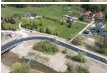
• 2022-05-12-Postępy prac na budowie mostu nad Poniczanką
