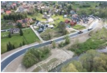
• 2022-05-12-Postępy prac na budowie mostu nad Poniczanką
