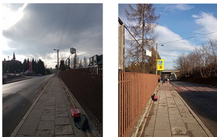
Zdjęcia przedstawiające miejsce montażu licznika
