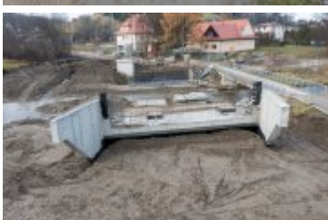
• 2021-11-22-Postępy prac na budowie mostu na Poniczance
