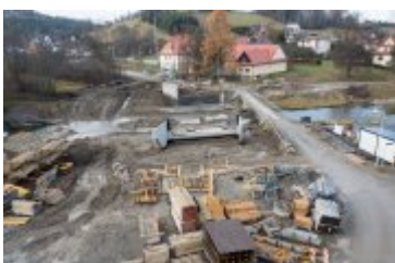
• 2021-11-22-Postępy prac na budowie mostu na Poniczance
