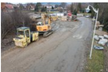
• 2021-11-22-Postępy prac na budowie mostu na Poniczance
