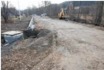
• 2021-11-22-Postępy prac na budowie mostu na Poniczance
