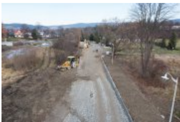
• 2021-11-22-Postępy prac na budowie mostu na Poniczance
