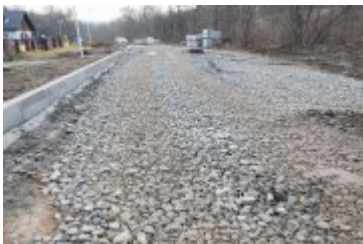
• 2021-11-22-Postępy prac na budowie mostu na Poniczance
