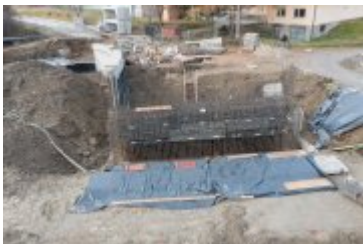
• 2021-11-22-Postępy prac na budowie mostu na Poniczance
