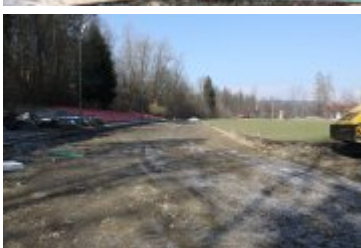
• 2020-04-03-Postępy prac przy remoncie stadionu miejskiego
