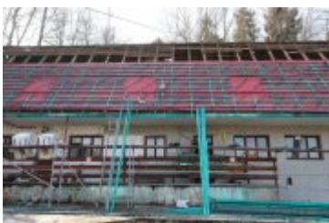
• 2020-04-03-Postępy prac przy remoncie stadionu miejskiego
