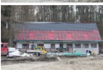
• 2020-04-03-Postępy prac przy remoncie stadionu miejskiego
