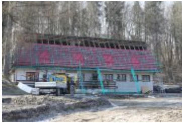
• 2020-04-03-Postępy prac przy remoncie stadionu miejskiego
