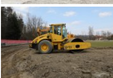
• 2020-04-03-Postępy prac przy remoncie stadionu miejskiego
