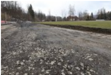
• 2020-04-03-Postępy prac przy remoncie stadionu miejskiego
