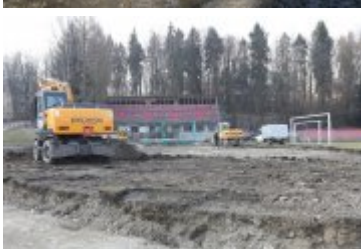
• 2020-04-03-Postępy prac przy remoncie stadionu miejskiego
