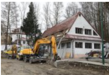
• 2020-04-03-Postępy prac przy remoncie stadionu miejskiego
