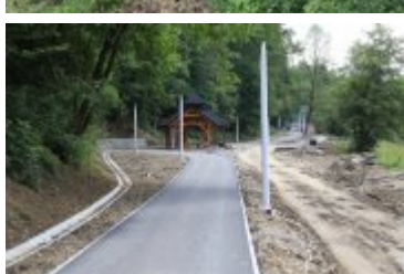
• 2019-06-24-Postępy prac na budowie bulwarów nad Poniczanką
