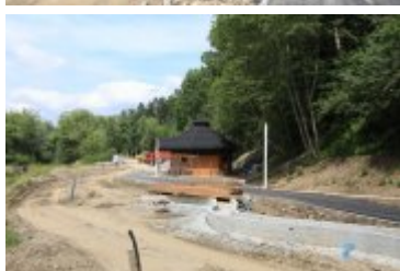
• 2019-06-24-Postępy prac na budowie bulwarów nad Poniczanką
