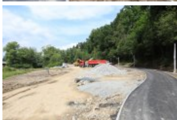
• 2019-06-24-Postępy prac na budowie bulwarów nad Poniczanką
