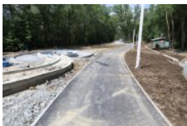
• 2019-06-24-Postępy prac na budowie bulwarów nad Poniczanką
