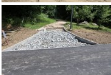
• 2019-06-24-Postępy prac na budowie bulwarów nad Poniczanką
