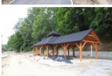
• 2019-06-24-Postępy prac na budowie bulwarów nad Poniczanką
