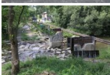
• 2019-06-24-Postępy prac na budowie bulwarów nad Poniczanką
