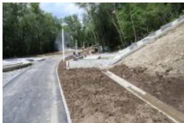
• 2019-06-24-Postępy prac na budowie bulwarów nad Poniczanką
