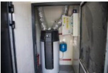
• 2020-05-07-Budowa Domu Solanki na finiszu
