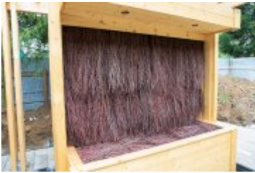
• 2020-05-07-Budowa Domu Solanki na finiszu
