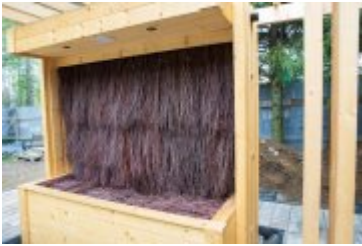
• 2020-05-07-Budowa Domu Solanki na finiszu
