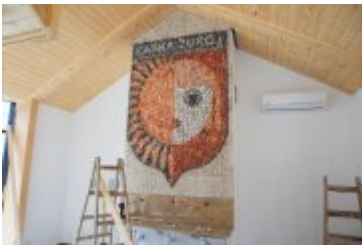
• 2020-05-07-Budowa Domu Solanki na finiszu
