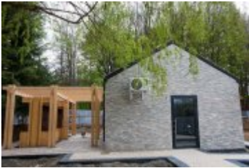
• 2020-05-07-Budowa Domu Solanki na finiszu
