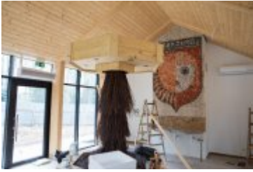
• 2020-05-07-Budowa Domu Solanki na finiszu
