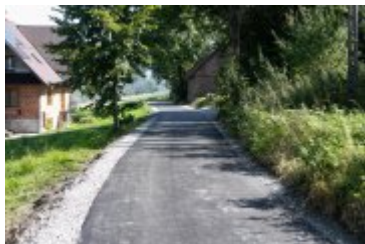
• 2020-09-22-Remont drogi na os. Piłatówka w Rdzawce
