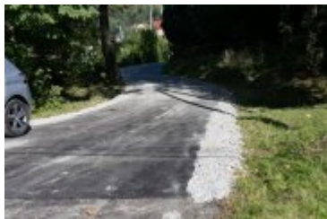
• 2020-09-22-Remont drogi na os. Piłatówka w Rdzawce
