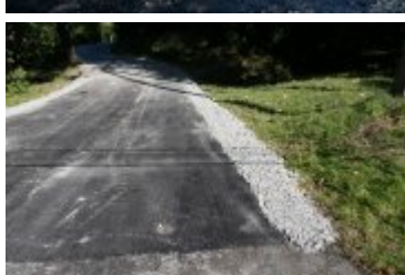
• 2020-09-22-Remont drogi na os. Piłatówka w Rdzawce
