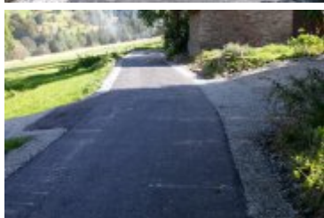
• 2020-09-22-Remont drogi na os. Piłatówka w Rdzawce
