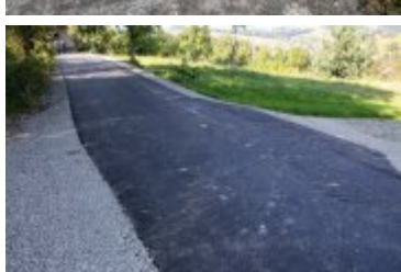
• 2020-09-22-Remont drogi na os. Piłatówka w Rdzawce
