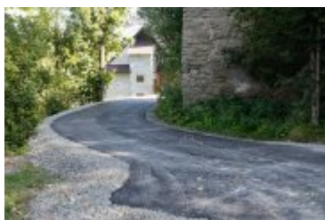
• 2020-09-22-Remont drogi na os. Piłatówka w Rdzawce
