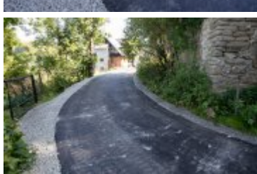
• 2020-09-22-Remont drogi na os. Piłatówka w Rdzawce
