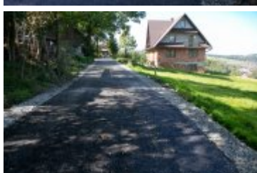
• 2020-09-22-Remont drogi na os. Piłatówka w Rdzawce
