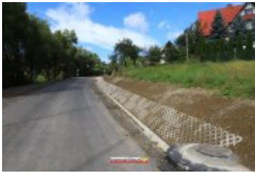
• 2017-09-21-Przebudowa drogi gminnej do oczyszczalni w Zarytem
