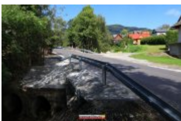
• 2017-09-21-Przebudowa drogi gminnej do oczyszczalni w Zarytem
