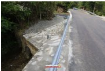
• 2017-09-21-Przebudowa drogi gminnej do oczyszczalni w Zarytem
