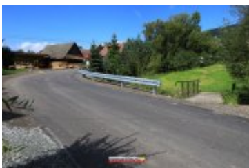
• 2017-09-21-Przebudowa drogi gminnej do oczyszczalni w Zarytem
