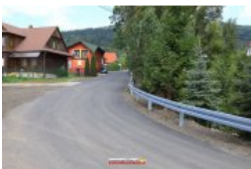
• 2017-09-21-Przebudowa drogi gminnej do oczyszczalni w Zarytem
