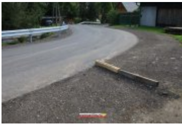
• 2017-09-21-Przebudowa drogi gminnej do oczyszczalni w Zarytem
