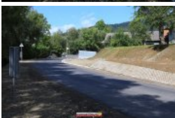
• 2017-09-21-Przebudowa drogi gminnej do oczyszczalni w Zarytem
