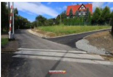
• 2017-09-21-Przebudowa drogi gminnej do oczyszczalni w Zarytem
