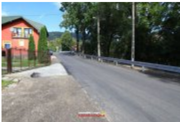
• 2017-09-21-Przebudowa drogi gminnej do oczyszczalni w Zarytem
