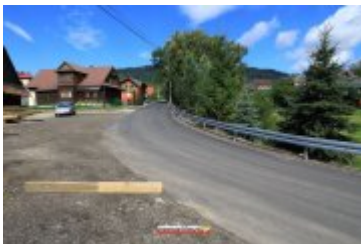
• 2017-09-21-Przebudowa drogi gminnej do oczyszczalni w Zarytem
