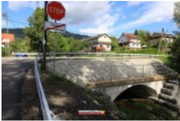
• 2017-09-21-Przebudowa drogi gminnej do oczyszczalni w Zarytem
