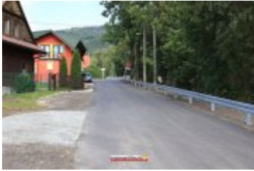
• 2017-09-21-Przebudowa drogi gminnej do oczyszczalni w Zarytem
