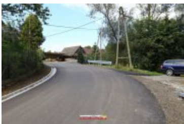
• 2017-09-21-Przebudowa drogi gminnej do oczyszczalni w Zarytem
