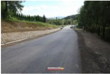
• 2017-09-21-Przebudowa drogi gminnej do oczyszczalni w Zarytem
