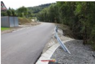
• 2017-09-21-Przebudowa drogi gminnej do oczyszczalni w Zarytem
