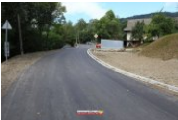
• 2017-09-21-Przebudowa drogi gminnej do oczyszczalni w Zarytem
