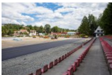
• 2020-07-16-Przebudowa Stadionu Miejskiego
