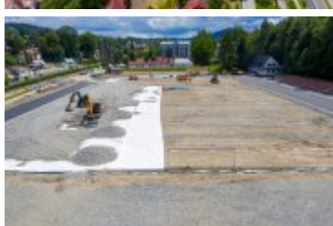
• 2020-07-16-Przebudowa Stadionu Miejskiego
