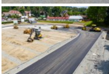
• 2020-07-16-Przebudowa Stadionu Miejskiego
