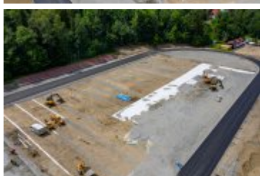
• 2020-07-16-Przebudowa Stadionu Miejskiego
