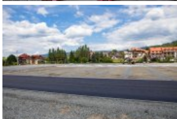
• 2020-07-16-Przebudowa Stadionu Miejskiego
