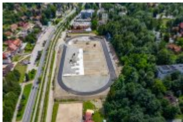
• 2020-07-16-Przebudowa Stadionu Miejskiego
