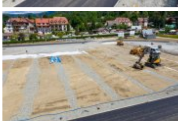
• 2020-07-16-Przebudowa Stadionu Miejskiego
