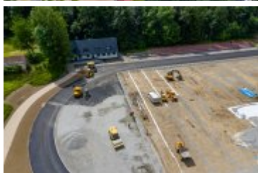
• 2020-07-16-Przebudowa Stadionu Miejskiego
