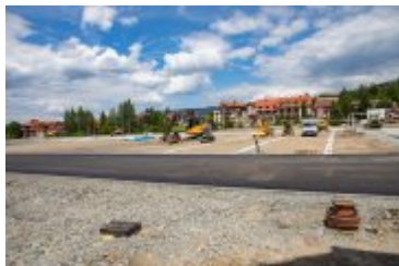
• 2020-07-16-Przebudowa Stadionu Miejskiego
