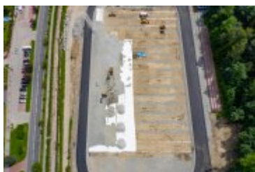
• 2020-07-16-Przebudowa Stadionu Miejskiego
