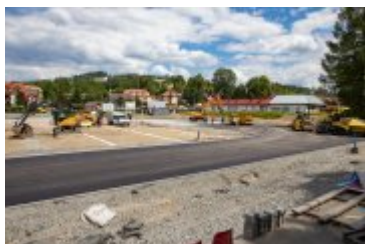
• 2020-07-16-Przebudowa Stadionu Miejskiego
