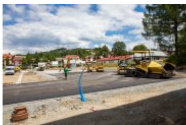
• 2020-07-16-Przebudowa Stadionu Miejskiego
