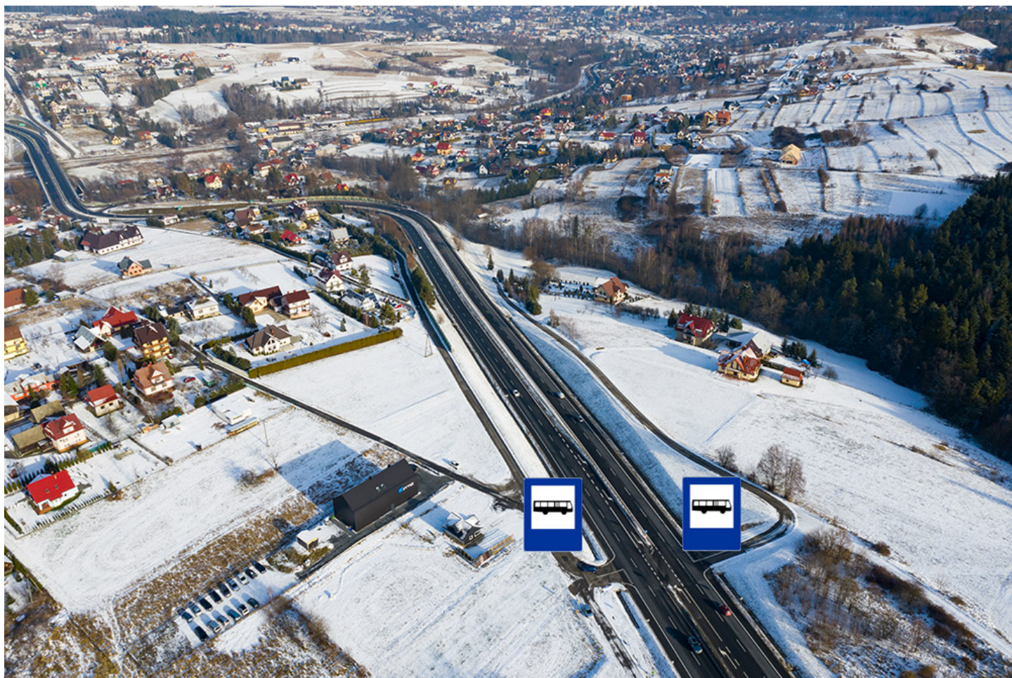
Na zdjęciu orientacyjnie miejsce nowych przystanków autobusowych.
