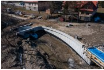
• 2022-03-14-Postępy prac na budowie mostu nad Poniczanką
