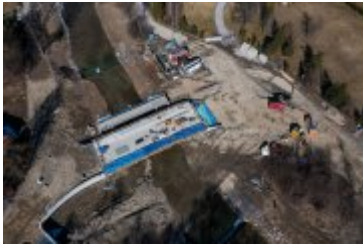
• 2022-03-14-Postępy prac na budowie mostu nad Poniczanką
