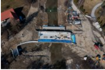
• 2022-03-14-Postępy prac na budowie mostu nad Poniczanką
