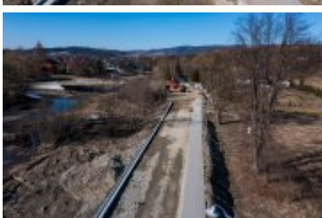
• 2022-03-14-Postępy prac na budowie mostu nad Poniczanką
