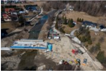
• 2022-03-14-Postępy prac na budowie mostu nad Poniczanką
