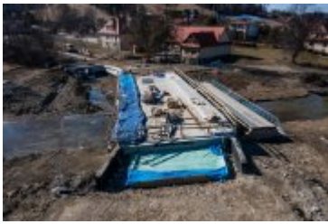
• 2022-03-14-Postępy prac na budowie mostu nad Poniczanką
