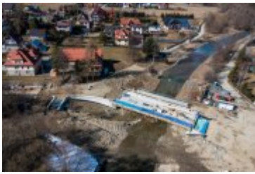
• 2022-03-14-Postępy prac na budowie mostu nad Poniczanką
