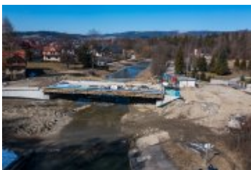
• 2022-03-14-Postępy prac na budowie mostu nad Poniczanką
