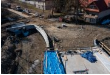
• 2022-03-14-Postępy prac na budowie mostu nad Poniczanką
