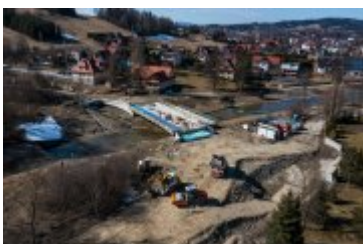
• 2022-03-14-Postępy prac na budowie mostu nad Poniczanką
