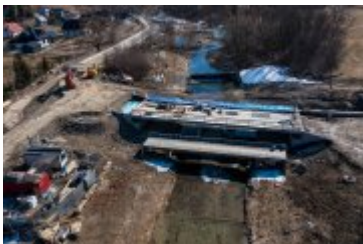
• 2022-03-14-Postępy prac na budowie mostu nad Poniczanką
