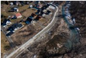
• 2022-03-14-Postępy prac na budowie mostu nad Poniczanką
