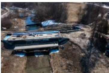
• 2022-03-14-Postępy prac na budowie mostu nad Poniczanką
