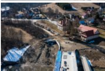
• 2022-03-14-Postępy prac na budowie mostu nad Poniczanką
