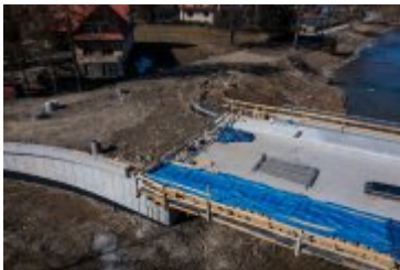
• 2022-03-14-Postępy prac na budowie mostu nad Poniczanką
