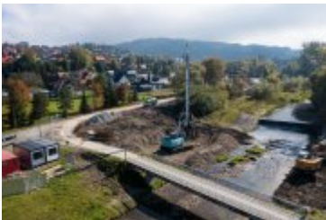
• 2021-10-08-Postępy prac na budowie mostu nad Poniczanką
