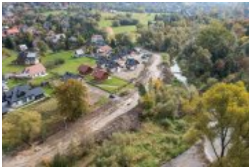
• 2021-10-08-Postępy prac na budowie mostu nad Poniczanką
