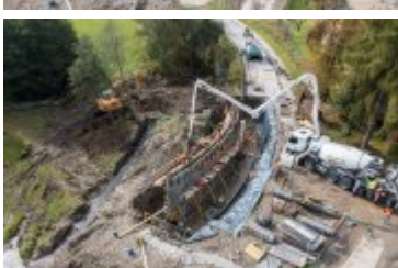
• 2021-10-08-Postępy prac na budowie mostu nad Poniczanką
