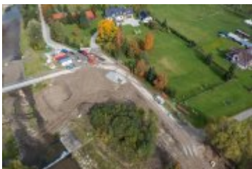
• 2021-10-08-Postępy prac na budowie mostu nad Poniczanką
