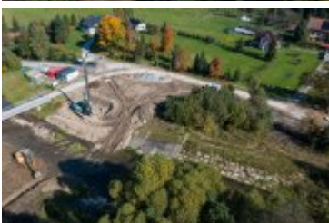
• 2021-10-08-Postępy prac na budowie mostu nad Poniczanką
