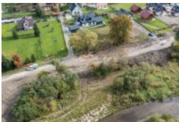
• 2021-10-08-Postępy prac na budowie mostu nad Poniczanką
