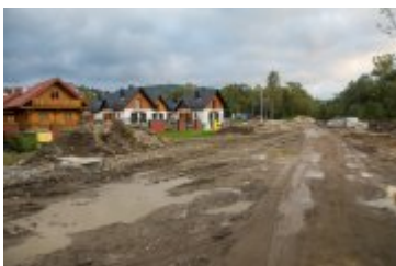
• 2021-10-08-Postępy prac na budowie mostu nad Poniczanką
