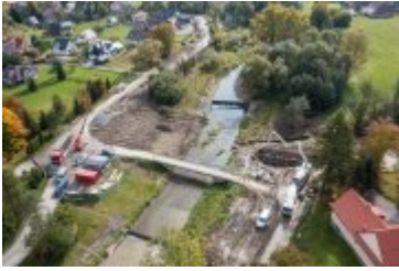
• 2021-10-08-Postępy prac na budowie mostu nad Poniczanką
