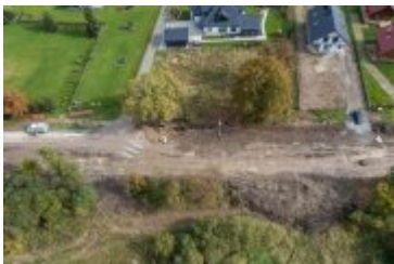
• 2021-10-08-Postępy prac na budowie mostu nad Poniczanką
