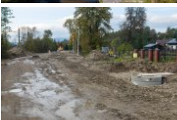
• 2021-10-08-Postępy prac na budowie mostu nad Poniczanką
