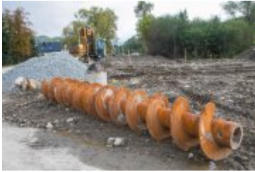
• 2021-10-08-Postępy prac na budowie mostu nad Poniczanką
