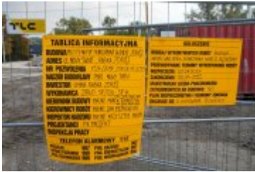
• 2021-10-08-Postępy prac na budowie mostu nad Poniczanką
