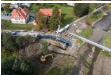
• 2021-10-08-Postępy prac na budowie mostu nad Poniczanką
