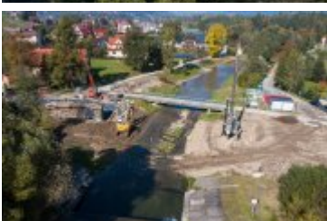
• 2021-10-08-Postępy prac na budowie mostu nad Poniczanką
