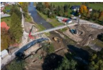
• 2021-10-08-Postępy prac na budowie mostu nad Poniczanką
