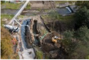
• 2021-10-08-Postępy prac na budowie mostu nad Poniczanką
