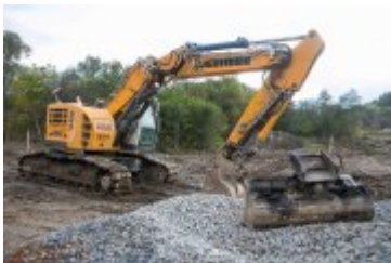
• 2021-10-08-Postępy prac na budowie mostu nad Poniczanką
