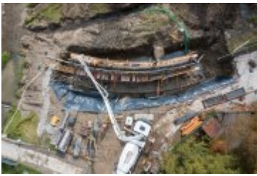
• 2021-10-08-Postępy prac na budowie mostu nad Poniczanką
