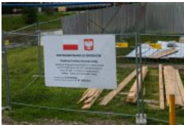
• 2021-10-08-Postępy prac na budowie mostu nad Poniczanką
