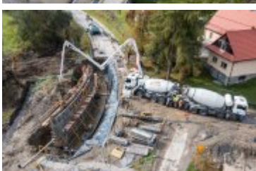
• 2021-10-08-Postępy prac na budowie mostu nad Poniczanką
