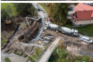
• 2021-10-08-Postępy prac na budowie mostu nad Poniczanką
