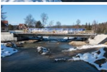
• 2022-02-10-Postępy prac na budowie mostu nad Poniczanką
