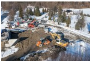
• 2022-02-10-Postępy prac na budowie mostu nad Poniczanką
