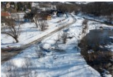
• 2022-02-10-Postępy prac na budowie mostu nad Poniczanką
