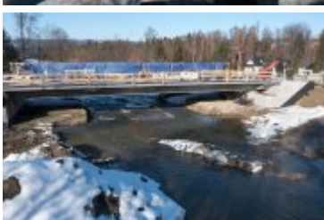
• 2022-02-10-Postępy prac na budowie mostu nad Poniczanką
