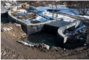
• 2022-02-10-Postępy prac na budowie mostu nad Poniczanką
