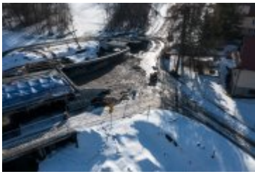
• 2022-02-10-Postępy prac na budowie mostu nad Poniczanką
