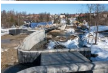
• 2022-02-10-Postępy prac na budowie mostu nad Poniczanką
