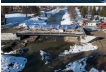
• 2022-02-10-Postępy prac na budowie mostu nad Poniczanką
