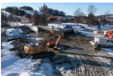
• 2022-02-10-Postępy prac na budowie mostu nad Poniczanką
