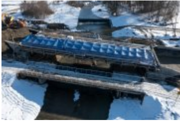
• 2022-02-10-Postępy prac na budowie mostu nad Poniczanką
