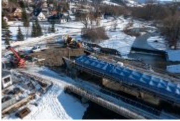
• 2022-02-10-Postępy prac na budowie mostu nad Poniczanką
