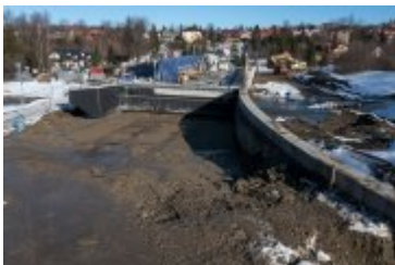
• 2022-02-10-Postępy prac na budowie mostu nad Poniczanką
