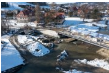
• 2022-02-10-Postępy prac na budowie mostu nad Poniczanką
