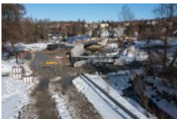
• 2022-02-10-Postępy prac na budowie mostu nad Poniczanką
