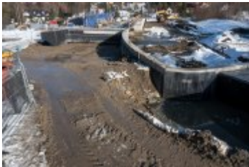
• 2022-02-10-Postępy prac na budowie mostu nad Poniczanką
