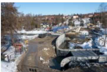
• 2022-02-10-Postępy prac na budowie mostu nad Poniczanką
