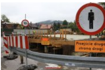
2017-09-20-Budowa mostu na Poniczance w Ponichach
