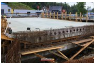
• 2017-09-20-Budowa mostu na Poniczance w Ponicach
