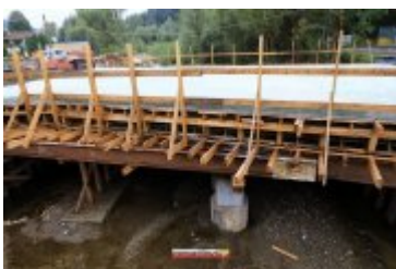
• 2017-09-20-Budowa mostu na Poniczance w Ponicach
