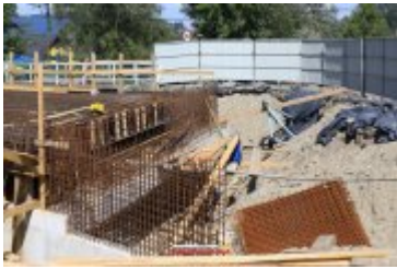
• 2017-09-20-Budowa mostu na Poniczance w Ponicach
