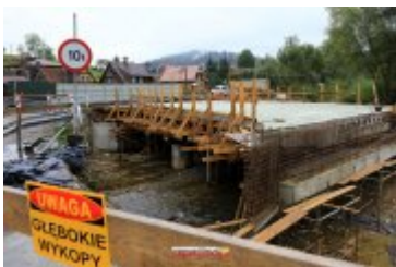
2017-09-20-Budowa mostu na Poniczance w Ponichach
