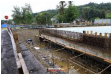
2017-09-20-Budowa mostu na Poniczance w Ponichach
