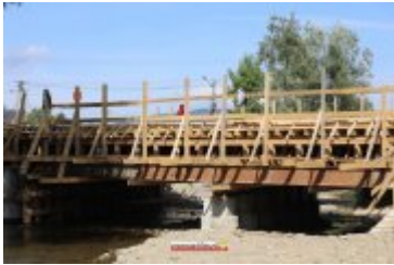
• 2017-09-20-Budowa mostu na Poniczance w Ponicach
