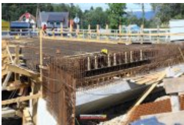
• 2017-09-20-Budowa mostu na Poniczance w Ponicach
