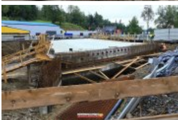
2017-09-20-Budowa mostu na Poniczance w Ponichach
