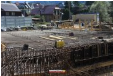
• 2017-09-20-Budowa mostu na Poniczance w Ponicach
