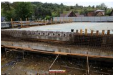
2017-09-20-Budowa mostu na Poniczance w Ponichach
