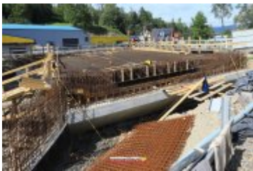
• 2017-09-20-Budowa mostu na Poniczance w Ponicach
