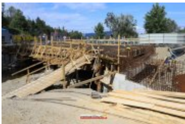
• 2017-09-20-Budowa mostu na Poniczance w Ponicach
