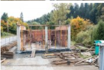
• 2021-10-07-Budowa remizy w Ponicach
