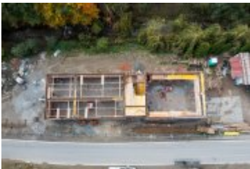
• 2021-10-07-Budowa remizy w Ponicach
