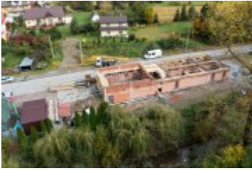
• 2021-10-07-Budowa remizy w Ponicach
