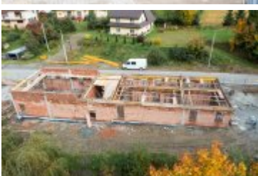
• 2021-10-07-Budowa remizy w Ponicach
