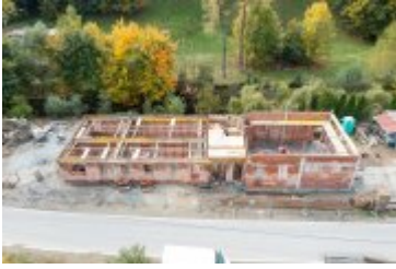
• 2021-10-07-Budowa remizy w Ponicach
