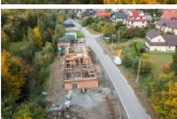
• 2021-10-07-Budowa remizy w Ponicach
