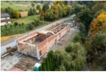
• 2021-10-07-Budowa remizy w Ponicach
