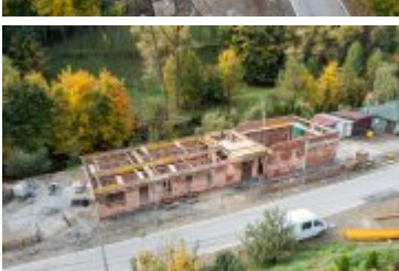
• 2021-10-07-Budowa remizy w Ponicach
