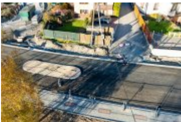
• 2024-10-25- Nowa nawierzchnia na ul. Jana Pawła II
