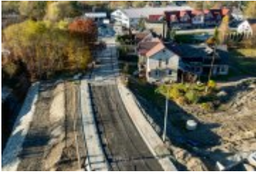
• 2024-10-25- Nowa nawierzchnia na ul. Jana Pawła II
