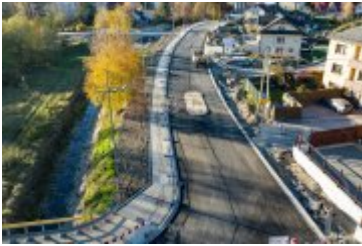
• 2024-10-25- Nowa nawierzchnia na ul. Jana Pawła II
