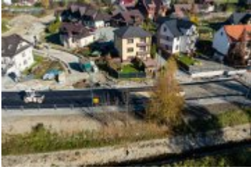
• 2024-10-25- Nowa nawierzchnia na ul. Jana Pawła II
