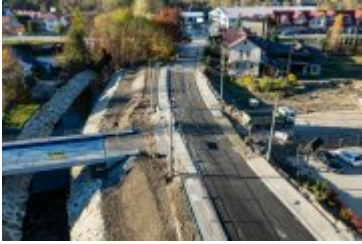
• 2024-10-25- Nowa nawierzchnia na ul. Jana Pawła II
