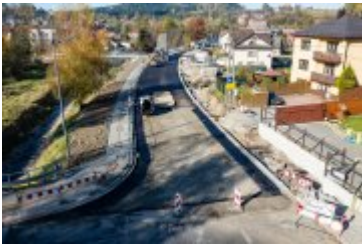
• 2024-10-25- Nowa nawierzchnia na ul. Jana Pawła II
