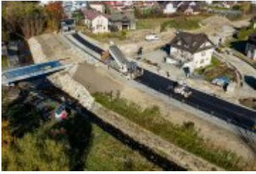
• 2024-10-25- Nowa nawierzchnia na ul. Jana Pawła II
