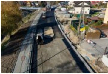
• 2024-10-25- Nowa nawierzchnia na ul. Jana Pawła II
