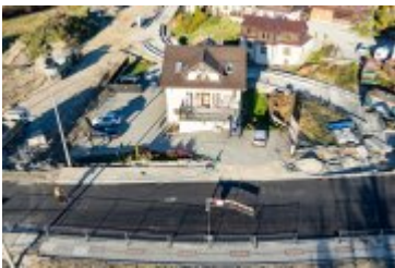
• 2024-10-25- Nowa nawierzchnia na ul. Jana Pawła II
