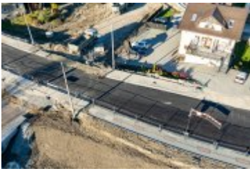
• 2024-10-25- Nowa nawierzchnia na ul. Jana Pawła II
