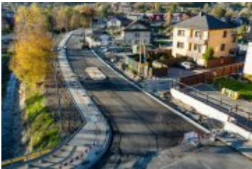
• 2024-10-25- Nowa nawierzchnia na ul. Jana Pawła II
