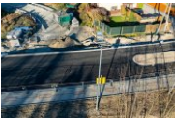
• 2024-10-25- Nowa nawierzchnia na ul. Jana Pawła II
