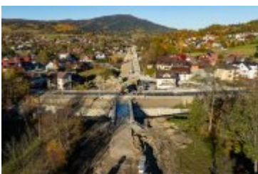
• 2024-10-25- Nowa nawierzchnia na ul. Jana Pawła II
