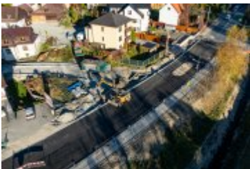
• 2024-10-25- Nowa nawierzchnia na ul. Jana Pawła II
