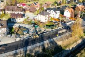
• 2024-10-25- Nowa nawierzchnia na ul. Jana Pawła II
