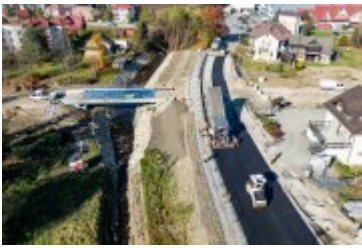
• 2024-10-25- Nowa nawierzchnia na ul. Jana Pawła II
