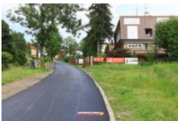
• 2017-06-30-Nowa nawierzchnia na Alei Tysiąclecia
