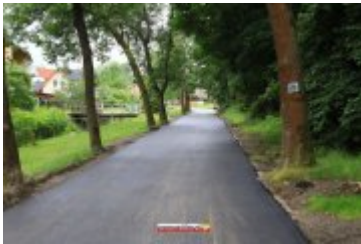
• 2017-06-30-Nowa nawierzchnia na Alei Tysiąclecia
