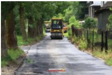
• 2017-06-30-Nowa nawierzchnia na Alei Tysiąclecia
