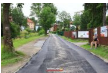
• 2017-06-30-Nowa nawierzchnia na Alei Tysiąclecia
