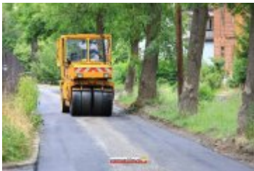
• 2017-06-30-Nowa nawierzchnia na Alei Tysiąclecia
