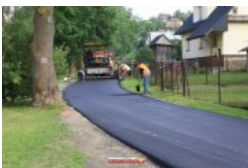
• 2017-06-30-Nowa nawierzchnia na Alei Tysiąclecia
