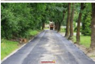
• 2017-06-30-Nowa nawierzchnia na Alei Tysiąclecia
