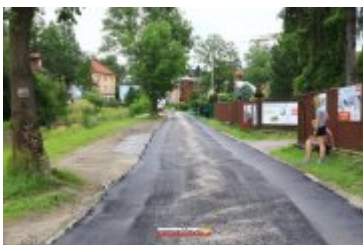
• 2017-06-30-Nowa nawierzchnia na Alei Tysiąclecia
