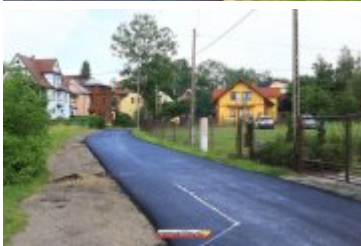
• 2017-06-30-Nowa nawierzchnia na Alei Tysiąclecia
