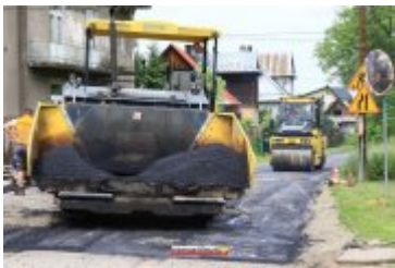
• 2017-06-30-Nowa nawierzchnia na Alei Tysiąclecia
