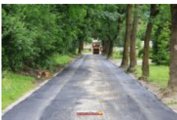
• 2017-06-30-Nowa nawierzchnia na Alei Tysiąclecia
