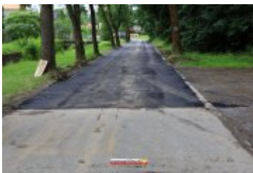
• 2017-06-30-Nowa nawierzchnia na Alei Tysiąclecia
