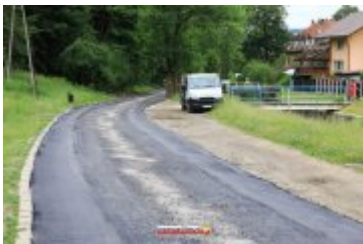
• 2017-06-30-Nowa nawierzchnia na Alei Tysiąclecia
