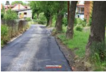
• 2017-06-30-Nowa nawierzchnia na Alei Tysiąclecia
