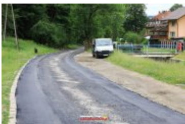
• 2017-06-30-Nowa nawierzchnia na Alei Tysiąclecia
