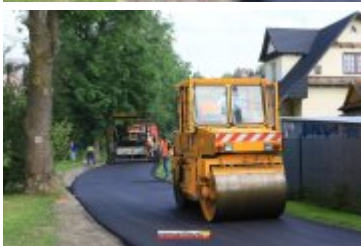
• 2017-06-30-Nowa nawierzchnia na Alei Tysiąclecia
