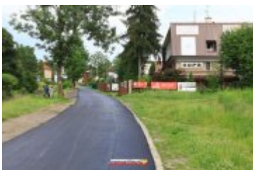
• 2017-06-30-Nowa nawierzchnia na Alei Tysiąclecia
