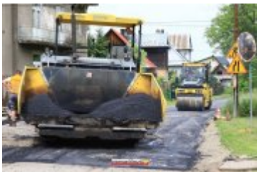
• 2017-06-30-Nowa nawierzchnia na Alei Tysiąclecia
