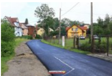
• 2017-06-30-Nowa nawierzchnia na Alei Tysiąclecia
