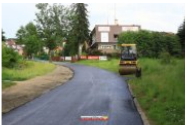
• 2017-06-30-Nowa nawierzchnia na Alei Tysiąclecia
