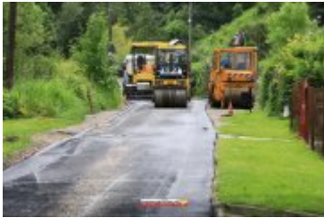
• 2017-06-30-Nowa nawierzchnia na Alei Tysiąclecia
