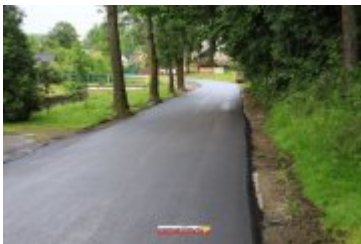
• 2017-06-30-Nowa nawierzchnia na Alei Tysiąclecia
