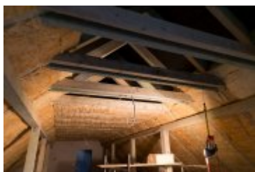
• 2022-11-04-Budowa remizy OSP w Ponicach
