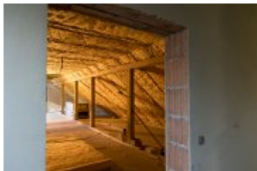
• 2022-11-04-Budowa remizy OSP w Ponicach
