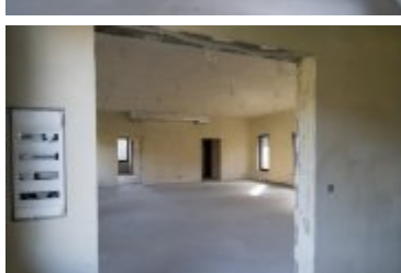
• 2022-11-04-Budowa remizy OSP w Ponicach
