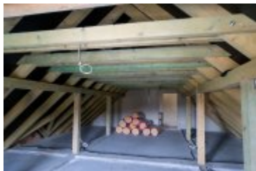
• 2022-11-04-Budowa remizy OSP w Ponicach
