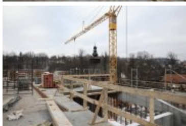
• 2018-02-21-Budowa nowego budynku Teatru Lalek Rabcio
