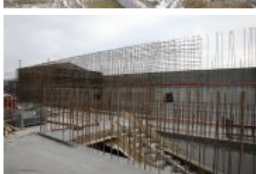
• 2018-02-21-Budowa nowego budynku Teatru Lalek Rabcio
