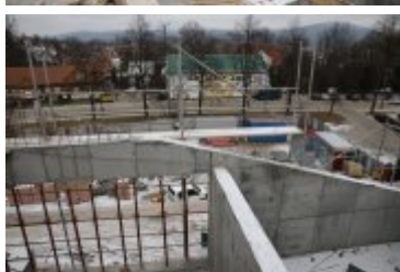
• 2018-02-21-Budowa nowego budynku Teatru Lalek Rabcio
