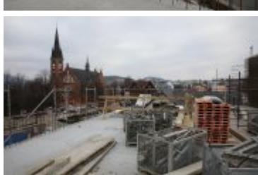
• 2018-02-21-Budowa nowego budynku Teatru Lalek Rabcio
