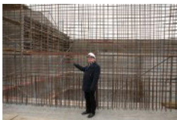
• 2018-02-21-Budowa nowego budynku Teatru Lalek Rabcio
