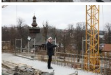
• 2018-02-21-Budowa nowego budynku Teatru Lalek Rabcio
