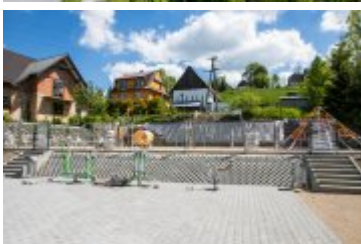
• 2021-06-04-Budowa placu zabaw w Rdzawce
