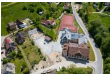
• 2021-06-04-Budowa placu zabaw w Rdzawce
