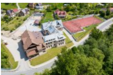
• 2021-06-04-Budowa placu zabaw w Rdzawce
