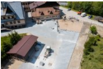
• 2021-06-04-Budowa placu zabaw w Rdzawce
