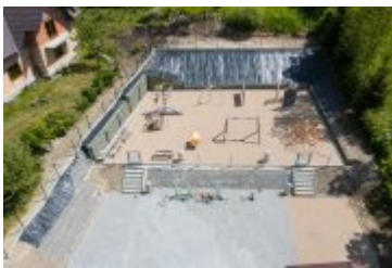
• 2021-06-04-Budowa placu zabaw w Rdzawce
