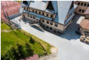
• 2021-06-04-Budowa placu zabaw w Rdzawce
