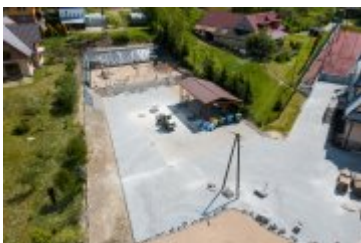
• 2021-06-04-Budowa placu zabaw w Rdzawce
