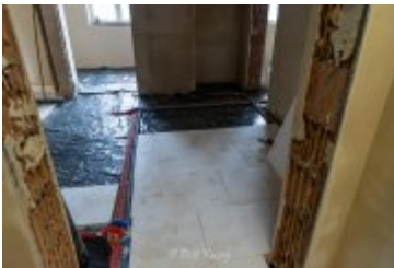
• 2025-02-18- Postępy prac na budowie szpitala
