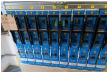
• 2025-02-18- Postępy prac na budowie szpitala
