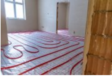
• 2025-02-18- Postępy prac na budowie szpitala
