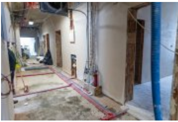
• 2025-02-18- Postępy prac na budowie szpitala
