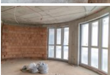
• 2025-02-18- Postępy prac na budowie szpitala
