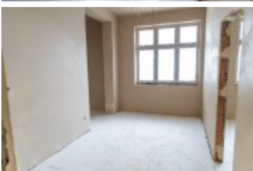
• 2025-02-18- Postępy prac na budowie szpitala
