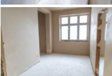
• 2025-02-18- Postępy prac na budowie szpitala
