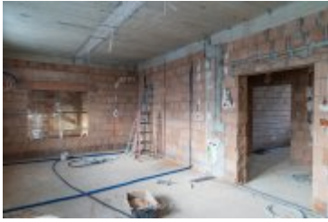
• 2025-02-18- Postępy prac na budowie szpitala
