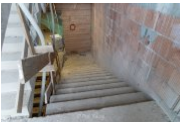
• 2025-02-18- Postępy prac na budowie szpitala
