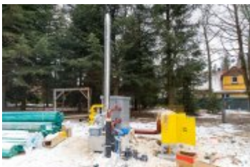
• 2025-02-18- Postępy prac na budowie szpitala
