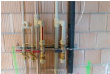
• 2025-02-18- Postępy prac na budowie szpitala
