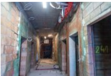
• 2025-02-18- Postępy prac na budowie szpitala
