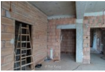
• 2025-02-18- Postępy prac na budowie szpitala
