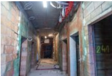
• 2025-02-18- Postępy prac na budowie szpitala
