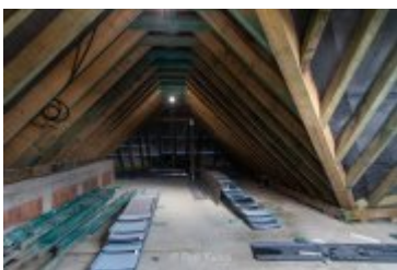
• 2025-02-18- Postępy prac na budowie szpitala
