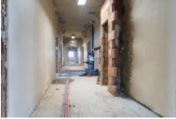
• 2025-02-18- Postępy prac na budowie szpitala
