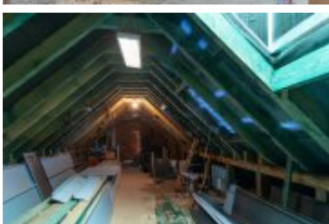
• 2025-02-18- Postępy prac na budowie szpitala
