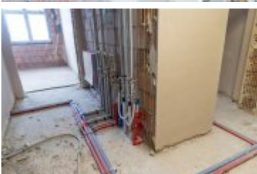
• 2025-02-18- Postępy prac na budowie szpitala
