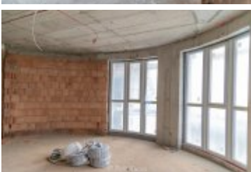
• 2025-02-18- Postępy prac na budowie szpitala
