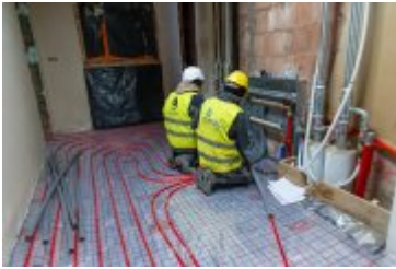
• 2025-02-18- Postępy prac na budowie szpitala
