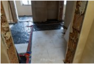
• 2025-02-18- Postępy prac na budowie szpitala
