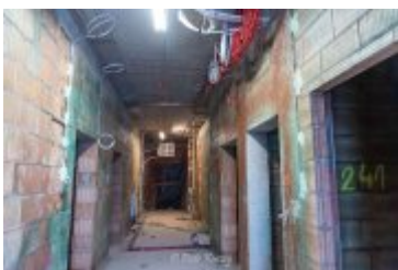
• 2025-02-18- Postępy prac na budowie szpitala
