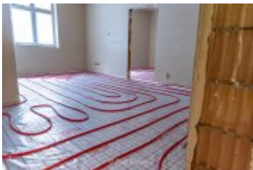
• 2025-02-18- Postępy prac na budowie szpitala
