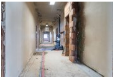
• 2025-02-18- Postępy prac na budowie szpitala
