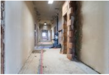
• 2025-02-18- Postępy prac na budowie szpitala
