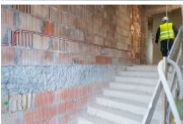
• 2025-02-18- Postępy prac na budowie szpitala
