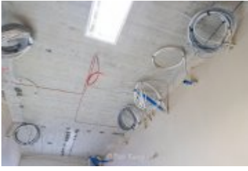
• 2025-02-18- Postępy prac na budowie szpitala
