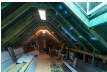
• 2025-02-18- Postępy prac na budowie szpitala
