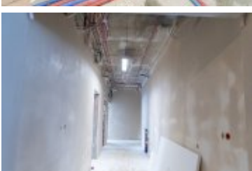
• 2025-02-18- Postępy prac na budowie szpitala
