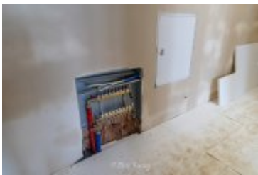
• 2025-02-18- Postępy prac na budowie szpitala
