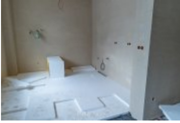
• 2025-02-18- Postępy prac na budowie szpitala
