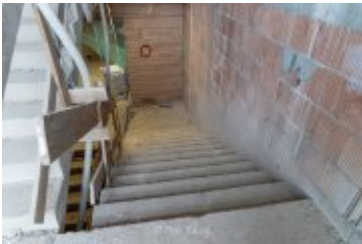
• 2025-02-18- Postępy prac na budowie szpitala
