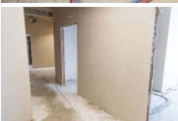
• 2025-02-18- Postępy prac na budowie szpitala
