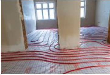
• 2025-02-18- Postępy prac na budowie szpitala
