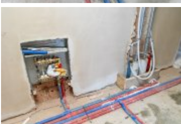
• 2025-02-18- Postępy prac na budowie szpitala
