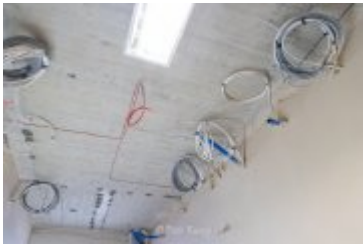
• 2025-02-18- Postępy prac na budowie szpitala
