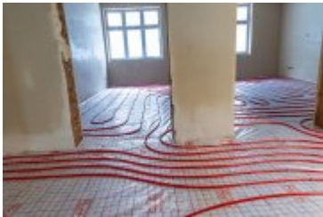
• 2025-02-18- Postępy prac na budowie szpitala
