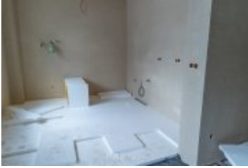
• 2025-02-18- Postępy prac na budowie szpitala
