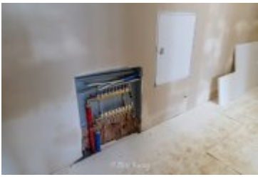
• 2025-02-18- Postępy prac na budowie szpitala
