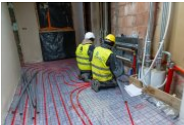
• 2025-02-18- Postępy prac na budowie szpitala
