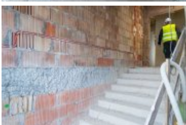
• 2025-02-18- Postępy prac na budowie szpitala
