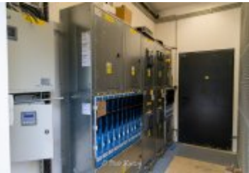
• 2025-02-18- Postępy prac na budowie szpitala
