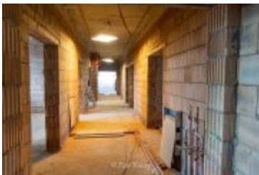
• 2025-02-18- Postępy prac na budowie szpitala
