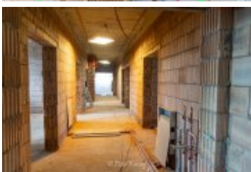
• 2025-02-18- Postępy prac na budowie szpitala
