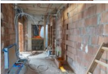
• 2025-02-18- Postępy prac na budowie szpitala
