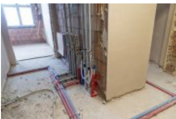
• 2025-02-18- Postępy prac na budowie szpitala
