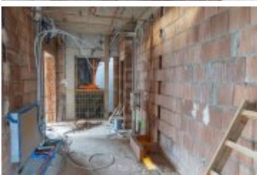
• 2025-02-18- Postępy prac na budowie szpitala
