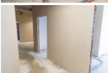
• 2025-02-18- Postępy prac na budowie szpitala
