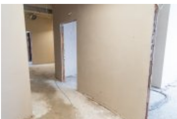
• 2025-02-18- Postępy prac na budowie szpitala
