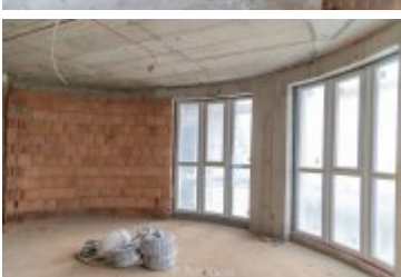
• 2025-02-18- Postępy prac na budowie szpitala
