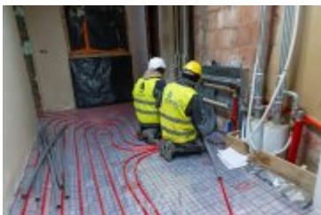
• 2025-02-18- Postępy prac na budowie szpitala
