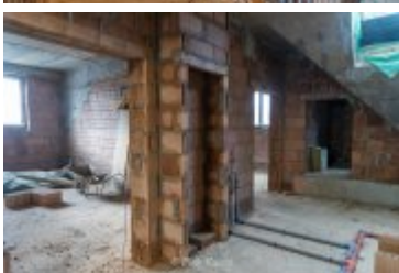
• 2025-02-18- Postępy prac na budowie szpitala
