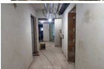
• 2025-02-18- Postępy prac na budowie szpitala
