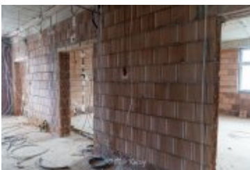
• 2025-02-18- Postępy prac na budowie szpitala
