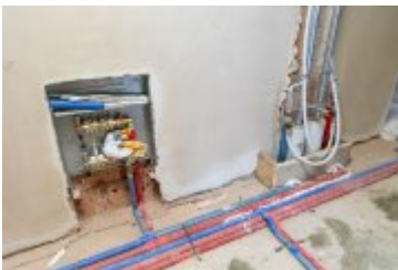
• 2025-02-18- Postępy prac na budowie szpitala
