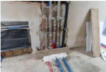
• 2025-02-18- Postępy prac na budowie szpitala
