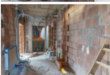
• 2025-02-18- Postępy prac na budowie szpitala
