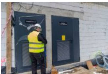
• 2025-02-18- Postępy prac na budowie szpitala
