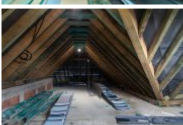
• 2025-02-18- Postępy prac na budowie szpitala
