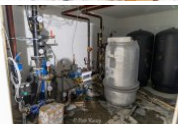
• 2025-02-18- Postępy prac na budowie szpitala
