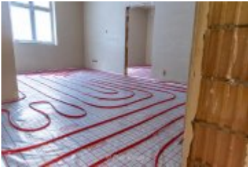
• 2025-02-18- Postępy prac na budowie szpitala
