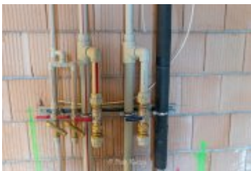
• 2025-02-18- Postępy prac na budowie szpitala
