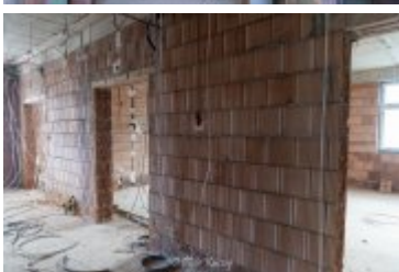
• 2025-02-18- Postępy prac na budowie szpitala
