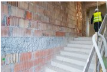
• 2025-02-18- Postępy prac na budowie szpitala
