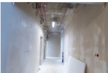
• 2025-02-18- Postępy prac na budowie szpitala
