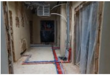
• 2025-02-18- Postępy prac na budowie szpitala
