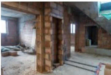
• 2025-02-18- Postępy prac na budowie szpitala
