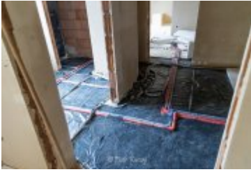
• 2025-02-18- Postępy prac na budowie szpitala
