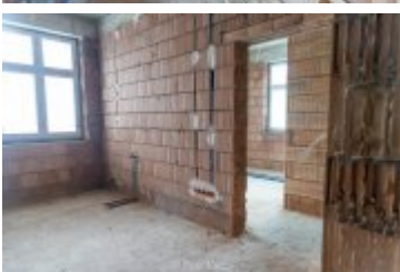
• 2025-02-18- Postępy prac na budowie szpitala
