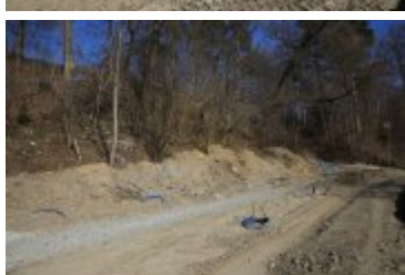
• 2019-04-01-Postępy prac na budowie bulwarów nad Poniczanką
