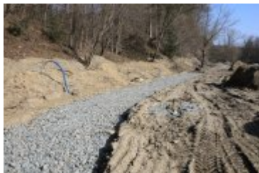
• 2019-04-01-Postępy prac na budowie bulwarów nad Poniczanką
