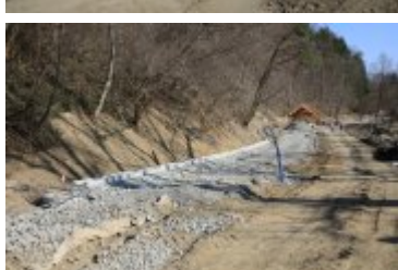
• 2019-04-01-Postępy prac na budowie bulwarów nad Poniczanką
