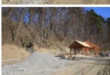
• 2019-04-01-Postępy prac na budowie bulwarów nad Poniczanką
