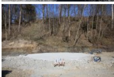
• 2019-04-01-Postępy prac na budowie bulwarów nad Poniczanką
