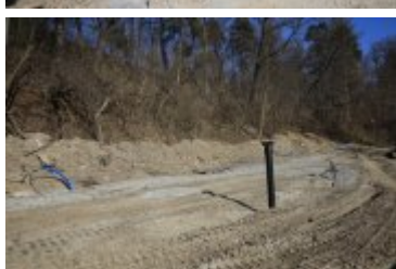
• 2019-04-01-Postępy prac na budowie bulwarów nad Poniczanką
