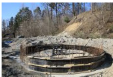
• 2019-04-01-Postępy prac na budowie bulwarów nad Poniczanką
