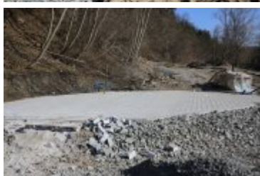
• 2019-04-01-Postępy prac na budowie bulwarów nad Poniczanką
