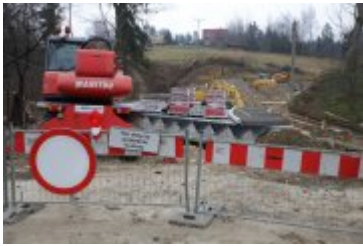
• 2018-11-18-Budowa mostu w Rdzawce
