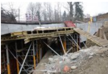
• 2018-11-18-Budowa mostu w Rdzawce
