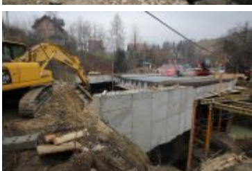
• 2018-11-18-Budowa mostu w Rdzawce
