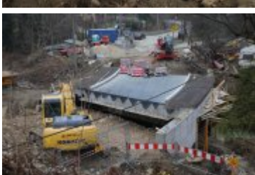
• 2018-11-18-Budowa mostu w Rdzawce
