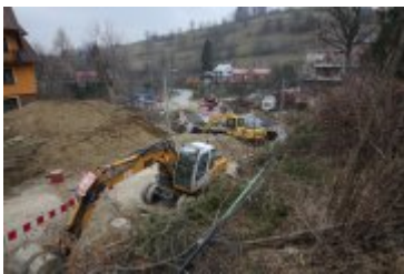
• 2018-11-18-Budowa mostu w Rdzawce
