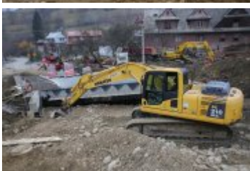
• 2018-11-18-Budowa mostu w Rdzawce
