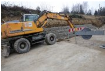
• 2018-11-18-Budowa mostu w Rdzawce
