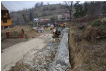
• 2018-11-18-Budowa mostu w Rdzawce
