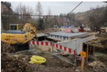
• 2018-11-18-Budowa mostu w Rdzawce
