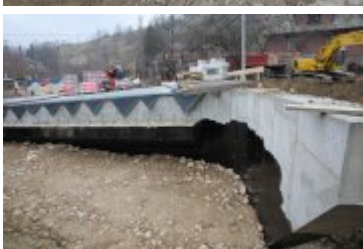
• 2018-11-18-Budowa mostu w Rdzawce
