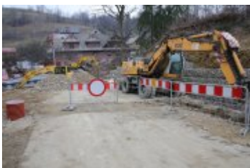
• 2018-11-18-Budowa mostu w Rdzawce
