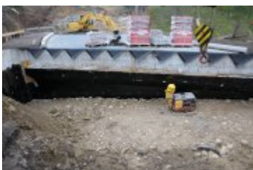
• 2018-11-18-Budowa mostu w Rdzawce
