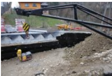
• 2018-11-18-Budowa mostu w Rdzawce
