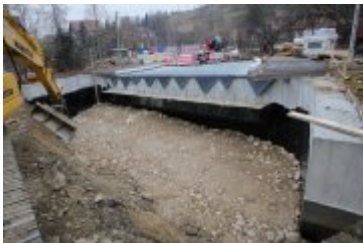
• 2018-11-18-Budowa mostu w Rdzawce
