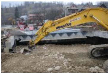
• 2018-11-18-Budowa mostu w Rdzawce
