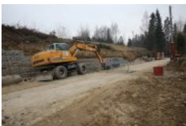
• 2018-11-18-Budowa mostu w Rdzawce
