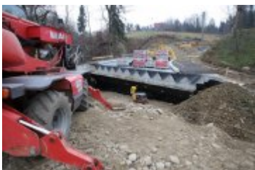
• 2018-11-18-Budowa mostu w Rdzawce
