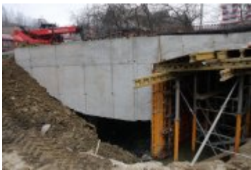
• 2018-11-18-Budowa mostu w Rdzawce
