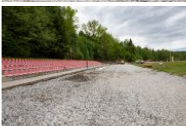
• 2020-06-05-Remont Stadionu Miejskiego
