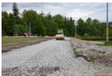
• 2020-06-05-Remont Stadionu Miejskiego
