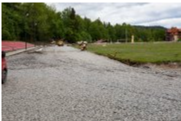
• 2020-06-05-Remont Stadionu Miejskiego
