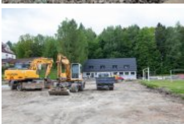
• 2020-06-05-Remont Stadionu Miejskiego
