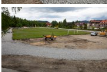
• 2020-06-05-Remont Stadionu Miejskiego
