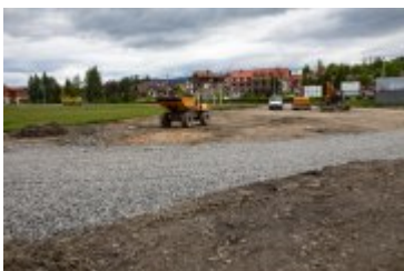
• 2020-06-05-Remont Stadionu Miejskiego
