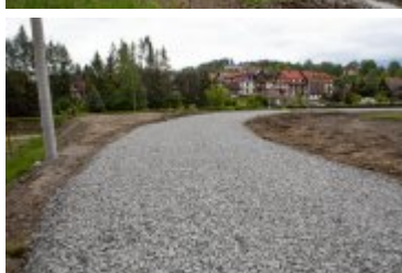
• 2020-06-05-Remont Stadionu Miejskiego
