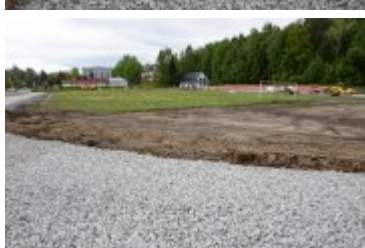
• 2020-06-05-Remont Stadionu Miejskiego
