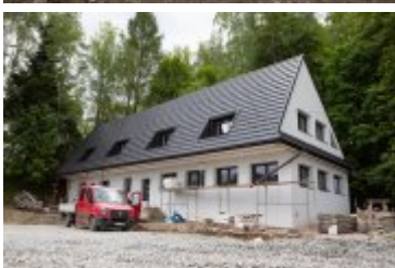
• 2020-06-05-Remont Stadionu Miejskiego
