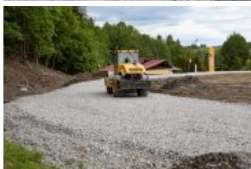
• 2020-06-05-Remont Stadionu Miejskiego
