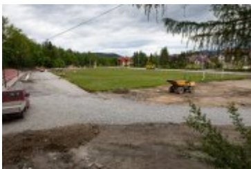
• 2020-06-05-Remont Stadionu Miejskiego
