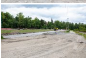
• 2020-06-05-Remont Stadionu Miejskiego
