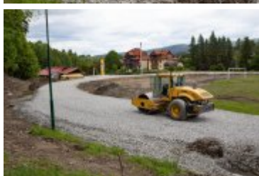
• 2020-06-05-Remont Stadionu Miejskiego
