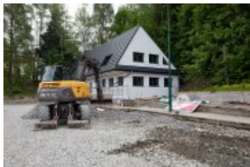
• 2020-06-05-Remont Stadionu Miejskiego
