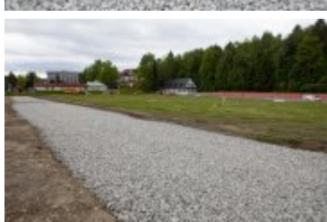
• 2020-06-05-Remont Stadionu Miejskiego
