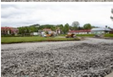
• 2020-06-05-Remont Stadionu Miejskiego
