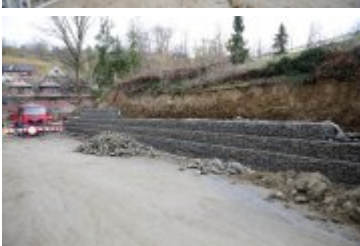
• 2018-10-26-Postępy prac na budowie mostu w Rdzawce
