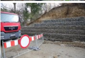
• 2018-10-26-Postępy prac na budowie mostu w Rdzawce
