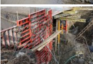
• 2018-10-26-Postępy prac na budowie mostu w Rdzawce
