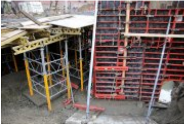
• 2018-10-26-Postępy prac na budowie mostu w Rdzawce
