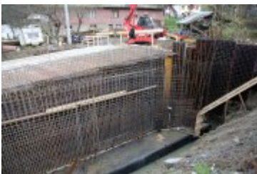
• 2018-10-26-Postępy prac na budowie mostu w Rdzawce
