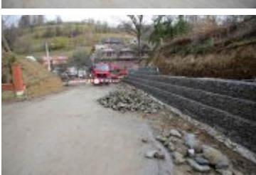
• 2018-10-26-Postępy prac na budowie mostu w Rdzawce
