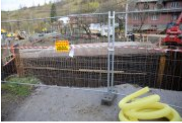
• 2018-10-26-Postępy prac na budowie mostu w Rdzawce
