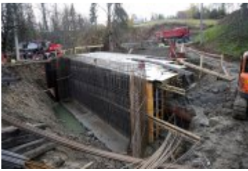
• 2018-10-26-Postępy prac na budowie mostu w Rdzawce
