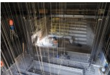
• 2019-08-27-Budowa parkingu przy Teatrze Rabcio
