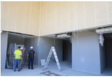
• 2019-08-27-Budowa parkingu przy Teatrze Rabcio
