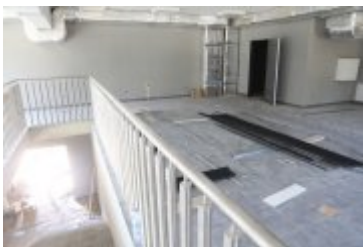
• 2019-08-27-Budowa parkingu przy Teatrze Rabcio
