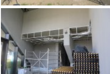
• 2019-08-27-Budowa parkingu przy Teatrze Rabcio
