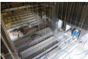
• 2019-08-27-Budowa parkingu przy Teatrze Rabcio
