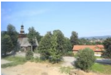
• 2019-08-27-Budowa parkingu przy Teatrze Rabcio
