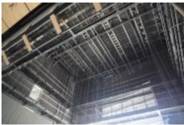
• 2019-08-27-Budowa parkingu przy Teatrze Rabcio
