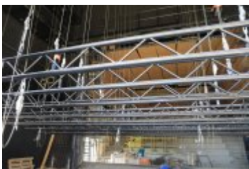
• 2019-08-27-Budowa parkingu przy Teatrze Rabcio
