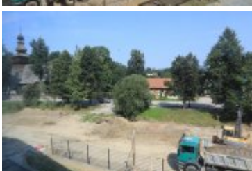
• 2019-08-27-Budowa parkingu przy Teatrze Rabcio
