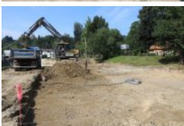
• 2019-08-27-Budowa parkingu przy Teatrze Rabcio
