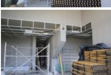
• 2019-08-27-Budowa parkingu przy Teatrze Rabcio
