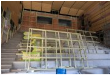
• 2019-08-27-Budowa parkingu przy Teatrze Rabcio
