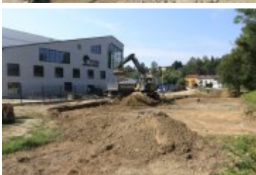
• 2019-08-27-Budowa parkingu przy Teatrze Rabcio
