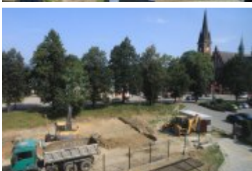
• 2019-08-27-Budowa parkingu przy Teatrze Rabcio
