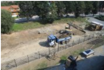
• 2019-08-27-Budowa parkingu przy Teatrze Rabcio
