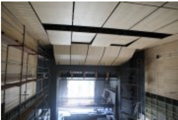
• 2019-08-27-Budowa parkingu przy Teatrze Rabcio
