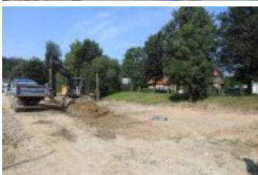
• 2019-08-27-Budowa parkingu przy Teatrze Rabcio
