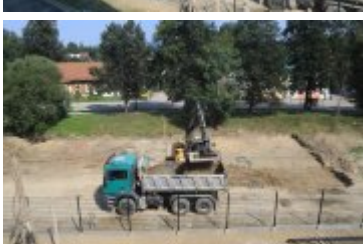
• 2019-08-27-Budowa parkingu przy Teatrze Rabcio
