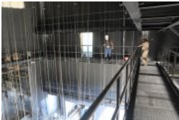
• 2019-08-27-Budowa parkingu przy Teatrze Rabcio
