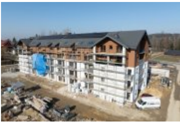
• 2025-02-10- Budowa bloku SIM na ul. Kilińskiego
