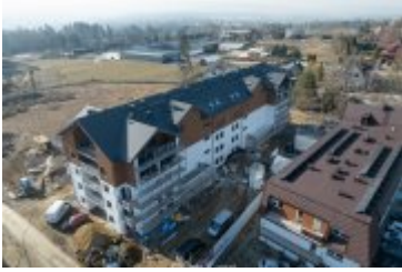
• 2025-02-10- Budowa bloku SIM na ul. Kilińskiego
