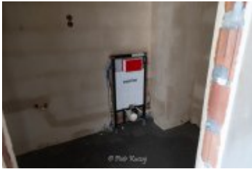
• 2025-02-10- Budowa bloku SIM na ul. Kilińskiego
