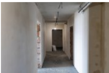
• 2025-02-10- Budowa bloku SIM na ul. Kilińskiego
