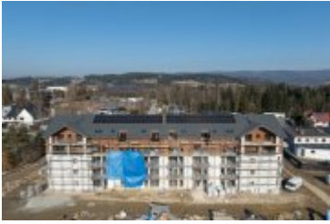
• 2025-02-10- Budowa bloku SIM na ul. Kilińskiego
