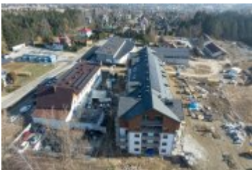
• 2025-02-10- Budowa bloku SIM na ul. Kilińskiego
