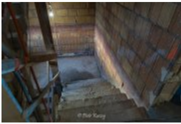
• 2025-02-10- Budowa bloku SIM na ul. Kilińskiego
