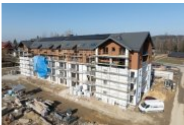
• 2025-02-10- Budowa bloku SIM na ul. Kilińskiego
