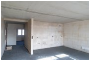
• 2025-02-10- Budowa bloku SIM na ul. Kilińskiego
