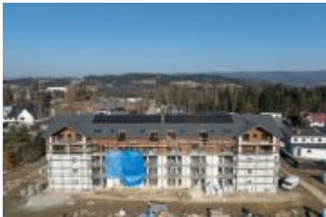
• 2025-02-10- Budowa bloku SIM na ul. Kilińskiego
