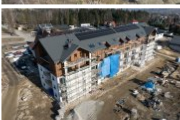
• 2025-02-10- Budowa bloku SIM na ul. Kilińskiego
