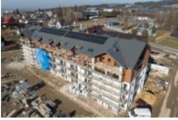
• 2025-02-10- Budowa bloku SIM na ul. Kilińskiego
