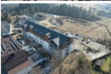
• 2025-02-10- Budowa bloku SIM na ul. Kilińskiego
