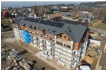
• 2025-02-10- Budowa bloku SIM na ul. Kilińskiego
