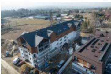
• 2025-02-10- Budowa bloku SIM na ul. Kilińskiego
