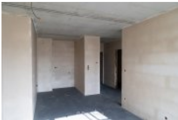
• 2025-02-10- Budowa bloku SIM na ul. Kilińskiego
