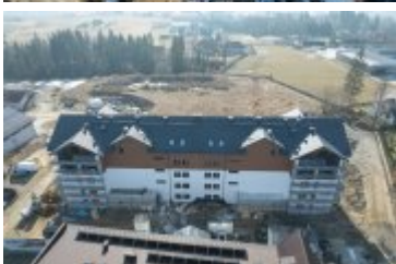
• 2025-02-10- Budowa bloku SIM na ul. Kilińskiego
