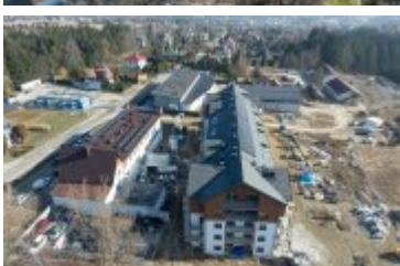
• 2025-02-10- Budowa bloku SIM na ul. Kilińskiego
