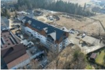
• 2025-02-10- Budowa bloku SIM na ul. Kilińskiego
