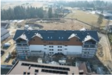
• 2025-02-10- Budowa bloku SIM na ul. Kilińskiego
