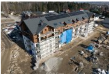
• 2025-02-10- Budowa bloku SIM na ul. Kilińskiego
