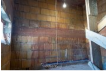
• 2025-02-10- Budowa bloku SIM na ul. Kilińskiego
