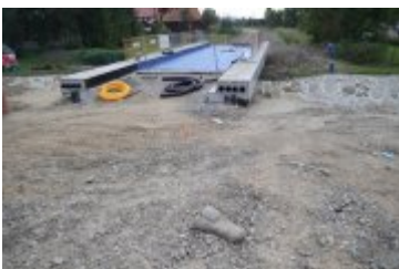
• 2024-09-19- Przejazd kolejowy w przebudowie
