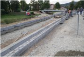
• 2024-09-19- Przejazd kolejowy w przebudowie
