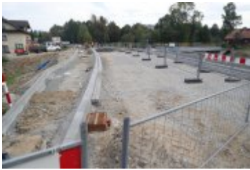
• 2024-09-19- Przejazd kolejowy w przebudowie
