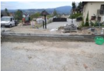
• 2024-09-19- Przejazd kolejowy w przebudowie
