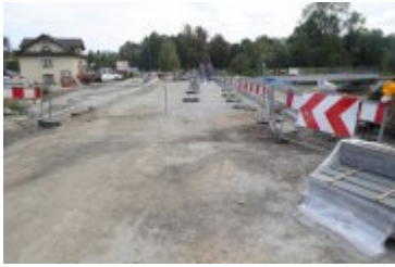
• 2024-09-19- Przejazd kolejowy w przebudowie
