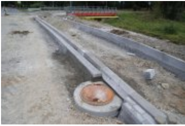
• 2024-09-19- Przejazd kolejowy w przebudowie
