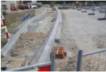
• 2024-09-19- Przejazd kolejowy w przebudowie
