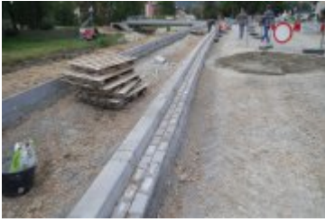
• 2024-09-19- Przejazd kolejowy w przebudowie
