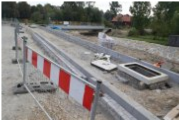
• 2024-09-19- Przejazd kolejowy w przebudowie
