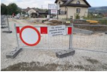
• 2024-09-19- Przejazd kolejowy w przebudowie
