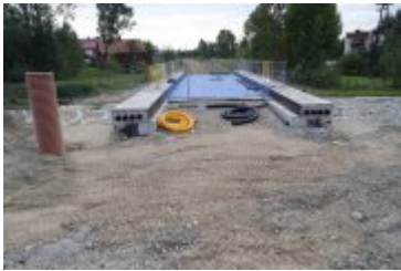
• 2024-09-19- Przejazd kolejowy w przebudowie
