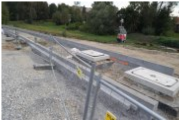
• 2024-09-19- Przejazd kolejowy w przebudowie
