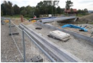
• 2024-09-19- Przejazd kolejowy w przebudowie
