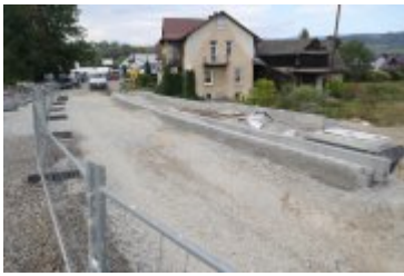
• 2024-09-19- Przejazd kolejowy w przebudowie
