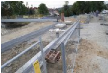
• 2024-09-19- Przejazd kolejowy w przebudowie
