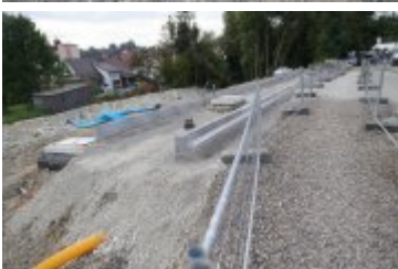
• 2024-09-19- Przejazd kolejowy w przebudowie
