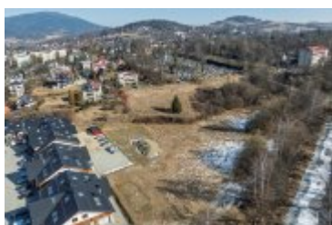
• 2025-02-22- Budowa pumtracka - wizualizacja i stan obecny
