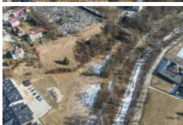
• 2025-02-22- Budowa pumtracka - wizualizacja i stan obecny
