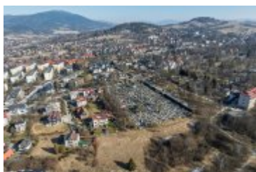
• 2025-02-22- Budowa pumtracka - wizualizacja i stan obecny
