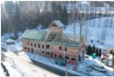
• 2022-02-15-Budowa remizy w Ponicach
