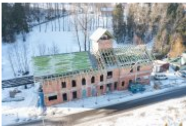
• 2022-02-15-Budowa remizy w Ponicach
