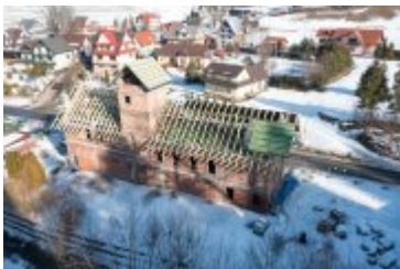
• 2022-02-15-Budowa remizy w Ponicach
