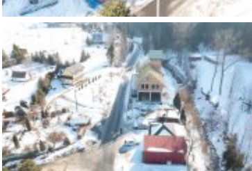
• 2022-02-15-Budowa remizy w Ponicach
