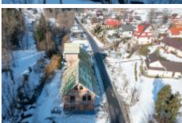
• 2022-02-15-Budowa remizy w Ponicach
