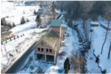
• 2022-02-15-Budowa remizy w Ponicach
