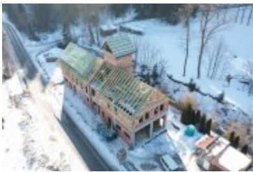
• 2022-02-15-Budowa remizy w Ponicach
