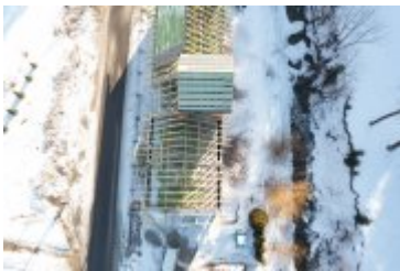
• 2022-02-15-Budowa remizy w Ponicach
