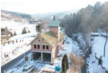
• 2022-02-15-Budowa remizy w Ponicach
