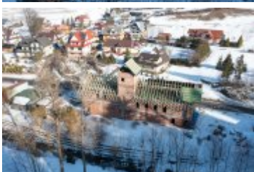
• 2022-02-15-Budowa remizy w Ponicach
