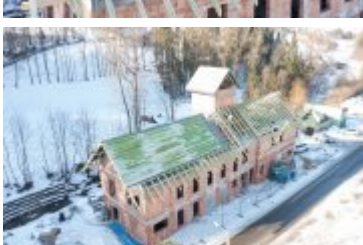
• 2022-02-15-Budowa remizy w Ponicach
