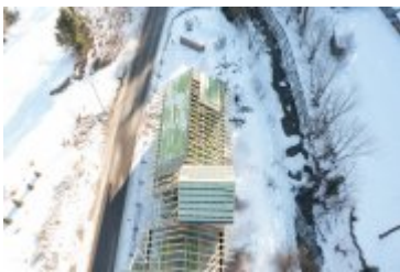
• 2022-02-15-Budowa remizy w Ponicach
