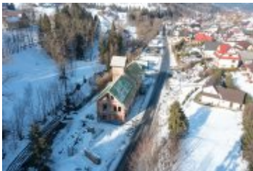
• 2022-02-15-Budowa remizy w Ponicach
