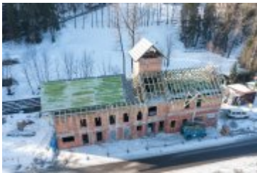
• 2022-02-15-Budowa remizy w Ponicach
