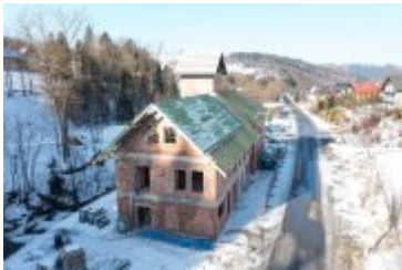
• 2022-02-15-Budowa remizy w Ponicach
