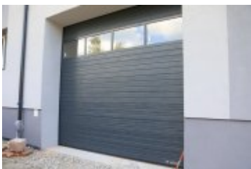
• 2019-06-27-Rozbudowa remizy OSP w Rdzawce
