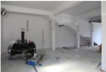
• 2019-06-27-Rozbudowa remizy OSP w Rdzawce
