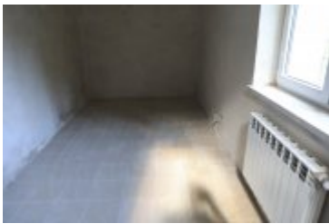
• 2019-06-27-Rozbudowa remizy OSP w Rdzawce
