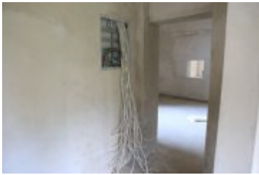
• 2019-06-27-Rozbudowa remizy OSP w Rdzawce
