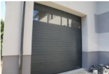
• 2019-06-27-Rozbudowa remizy OSP w Rdzawce
