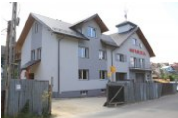
• 2019-06-27-Rozbudowa remizy OSP w Rdzawce
