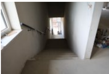
• 2019-06-27-Rozbudowa remizy OSP w Rdzawce
