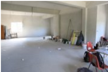
• 2019-06-27-Rozbudowa remizy OSP w Rdzawce
