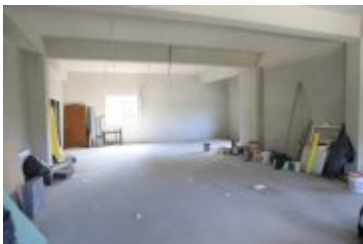
• 2019-06-27-Rozbudowa remizy OSP w Rdzawce
