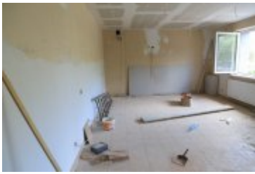
• 2019-06-27-Rozbudowa remizy OSP w Rdzawce
