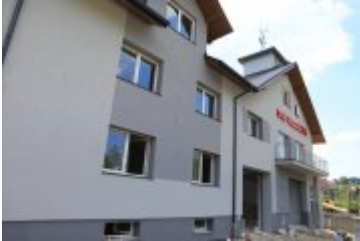
• 2019-06-27-Rozbudowa remizy OSP w Rdzawce
