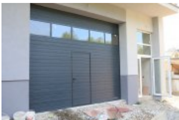
• 2019-06-27-Rozbudowa remizy OSP w Rdzawce
