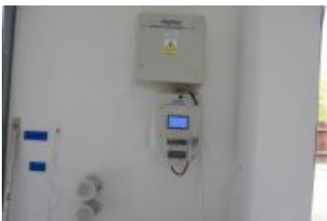
• 2019-06-27-Rozbudowa remizy OSP w Rdzawce
