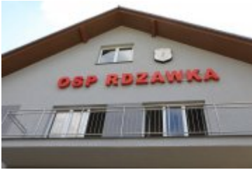
• 2019-06-27-Rozbudowa remizy OSP w Rdzawce
