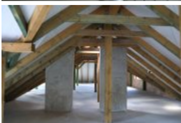
• 2019-06-27-Rozbudowa remizy OSP w Rdzawce
