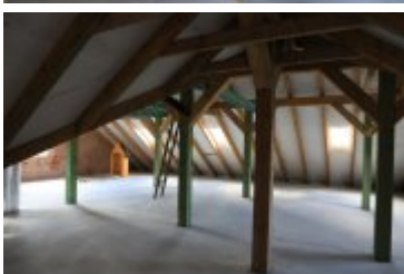
• 2019-06-27-Rozbudowa remizy OSP w Rdzawce
