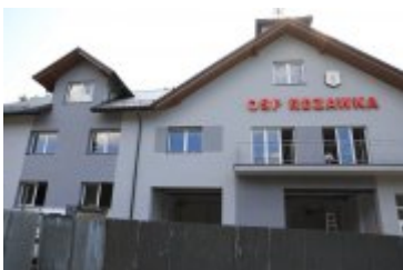
• 2019-06-27-Rozbudowa remizy OSP w Rdzawce
