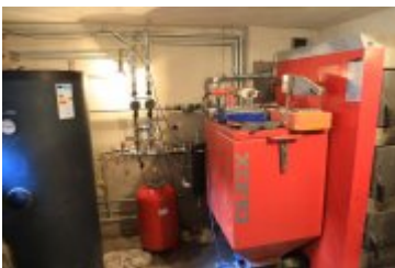
• 2019-06-27-Rozbudowa remizy OSP w Rdzawce
