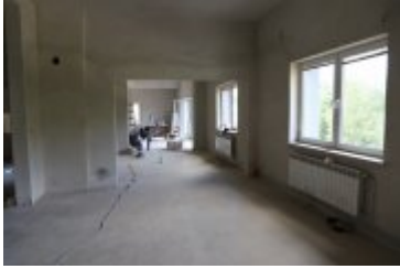
• 2019-06-27-Rozbudowa remizy OSP w Rdzawce
