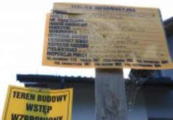
• 2019-06-27-Rozbudowa remizy OSP w Rdzawce
