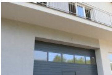
• 2019-06-27-Rozbudowa remizy OSP w Rdzawce
