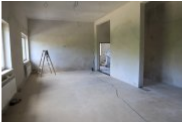
• 2019-06-27-Rozbudowa remizy OSP w Rdzawce
