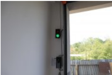
• 2019-06-27-Rozbudowa remizy OSP w Rdzawce
