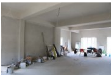
• 2019-06-27-Rozbudowa remizy OSP w Rdzawce
