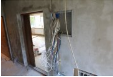
• 2019-06-27-Rozbudowa remizy OSP w Rdzawce
