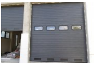
• 2022-08-30-Budowa remizy OSP w Ponicach
