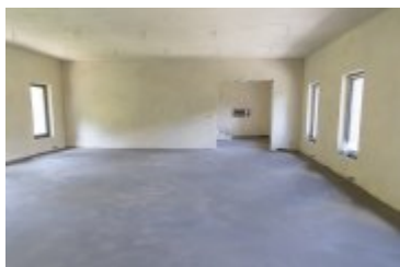
• 2022-08-30-Budowa remizy OSP w Ponicach
