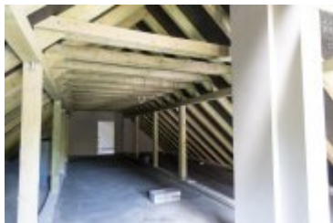
• 2022-08-30-Budowa remizy OSP w Ponicach
