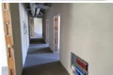
• 2022-08-30-Budowa remizy OSP w Ponicach
