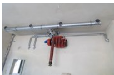
• 2022-08-30-Budowa remizy OSP w Ponicach
