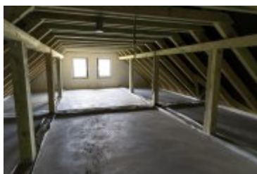
• 2022-08-30-Budowa remizy OSP w Ponicach
