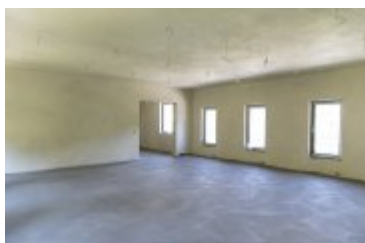
• 2022-08-30-Budowa remizy OSP w Ponicach
