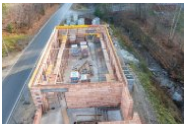
• 2021-11-13- Budowa remizy OSP w Ponicach
