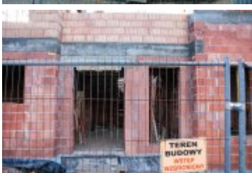
• 2021-11-13- Budowa remizy OSP w Ponicach
