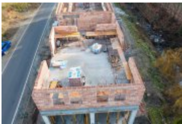
• 2021-11-13- Budowa remizy OSP w Ponicach
