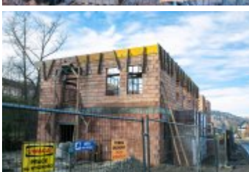
• 2021-11-13- Budowa remizy OSP w Ponicach
