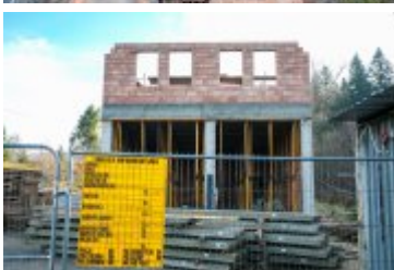
• 2021-11-13- Budowa remizy OSP w Ponicach
