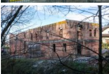
• 2021-11-13- Budowa remizy OSP w Ponicach
