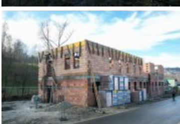
• 2021-11-13- Budowa remizy OSP w Ponicach
