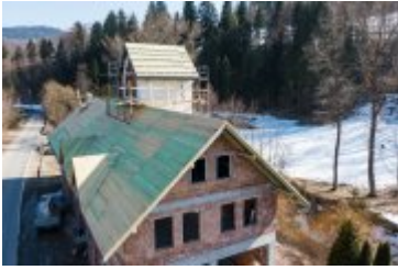
• 2022-03-24-Budowa remizy OSP w Ponicach
