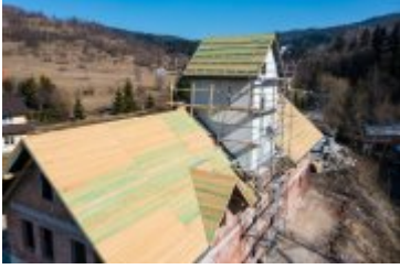
• 2022-03-24-Budowa remizy OSP w Ponicach
