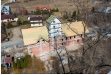
• 2022-03-24-Budowa remizy OSP w Ponicach
