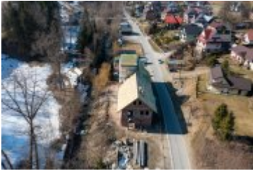
• 2022-03-24-Budowa remizy OSP w Ponicach
