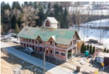
• 2022-03-24-Budowa remizy OSP w Ponicach
