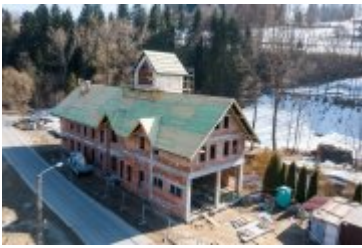
• 2022-03-24-Budowa remizy OSP w Ponicach
