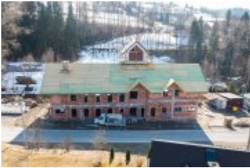
• 2022-03-24-Budowa remizy OSP w Ponicach
