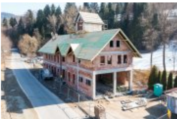
• 2022-03-24-Budowa remizy OSP w Ponicach
