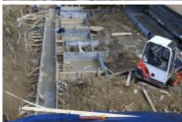
• 2017-09-13-Rozbudowa remizy OSP w Rdzawce
