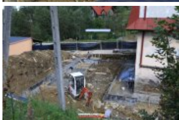
• 2017-09-13-Rozbudowa remizy OSP w Rdzawce
