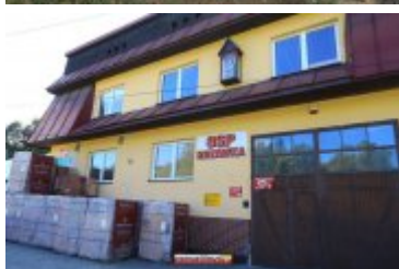
• 2017-09-13-Rozbudowa remizy OSP w Rdzawce
