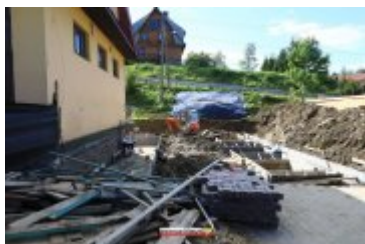
• 2017-09-13-Rozbudowa remizy OSP w Rdzawce
