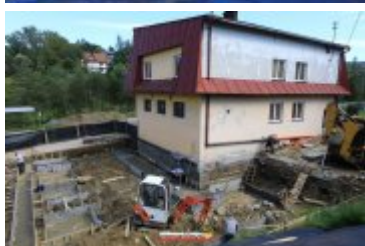
• 2017-09-13-Rozbudowa remizy OSP w Rdzawce
