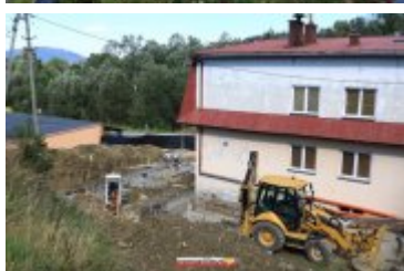
• 2017-09-13-Rozbudowa remizy OSP w Rdzawce
