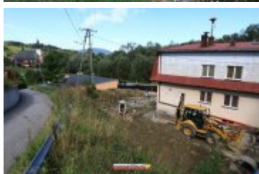
• 2017-09-13-Rozbudowa remizy OSP w Rdzawce
