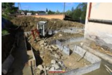
• 2017-09-13-Rozbudowa remizy OSP w Rdzawce
