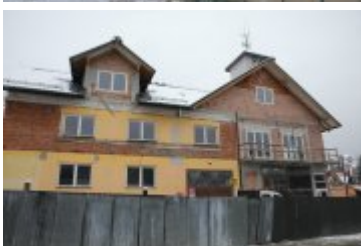
• 2018-12-14-Budowa remizy OSP w Rdzawce
