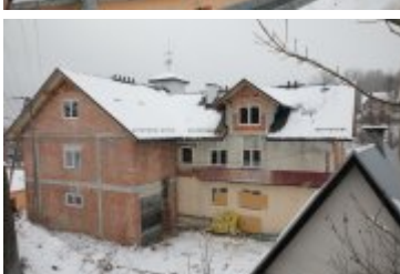
• 2018-12-14-Budowa remizy OSP w Rdzawce
