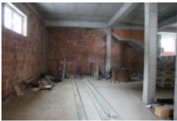
• 2018-12-14-Budowa remizy OSP w Rdzawce
