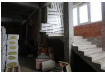
• 2018-12-14-Budowa remizy OSP w Rdzawce
