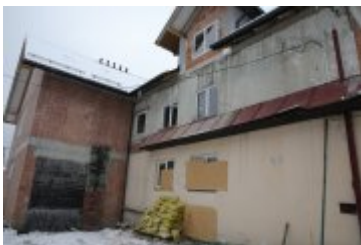
• 2018-12-14-Budowa remizy OSP w Rdzawce
