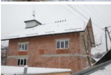
• 2018-12-14-Budowa remizy OSP w Rdzawce
