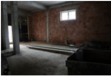
• 2018-12-14-Budowa remizy OSP w Rdzawce
