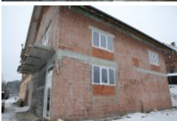
• 2018-12-14-Budowa remizy OSP w Rdzawce
