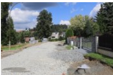
• 2020-08-21-Remont drogi osiedlowej na Traczykówe
