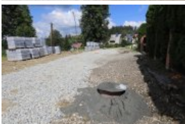
• 2020-08-21-Remont drogi osiedlowej na Traczykówe
