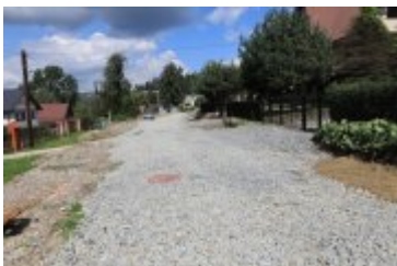
• 2020-08-21-Remont drogi osiedlowej na Traczykówe
