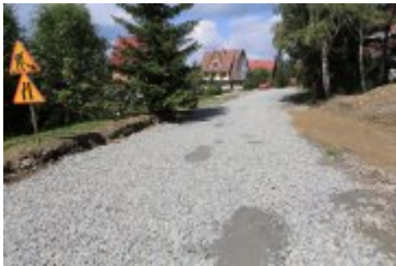
• 2020-08-21-Remont drogi osiedlowej na Traczykówe
