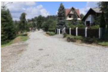
• 2020-08-21-Remont drogi osiedlowej na Traczykówe
