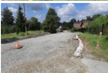
• 2020-08-21-Remont drogi osiedlowej na Traczykówe
