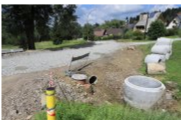
• 2020-08-21-Remont drogi osiedlowej na Traczykówe
