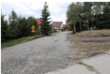
• 2020-08-21-Remont drogi osiedlowej na Traczykówe
