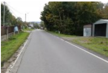
• 2022-10-06-Remont drogi w Ponicach
