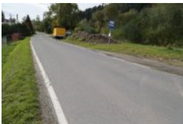
• 2022-10-06-Remont drogi w Ponicach
