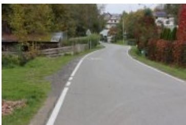
• 2022-10-06-Remont drogi w Ponicach
