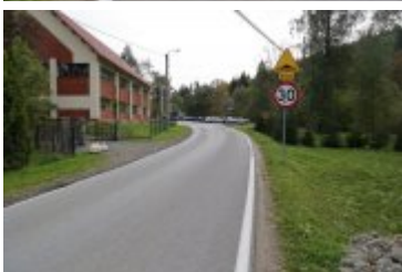
• 2022-10-06-Remont drogi w Ponicach
