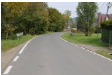
• 2022-10-06-Remont drogi w Ponicach
