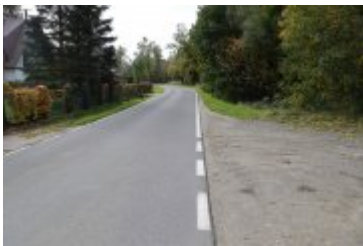
• 2022-10-06-Remont drogi w Ponicach
