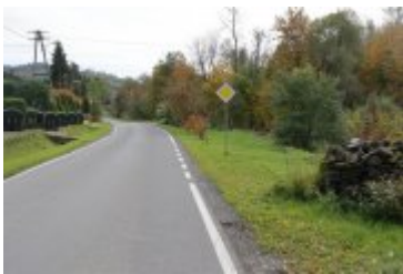
• 2022-10-06-Remont drogi w Ponicach
