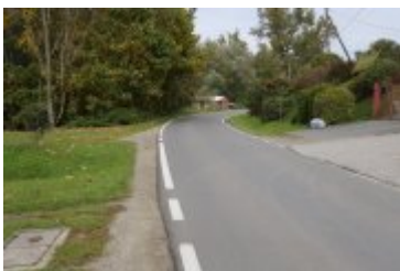
• 2022-10-06-Remont drogi w Ponicach
