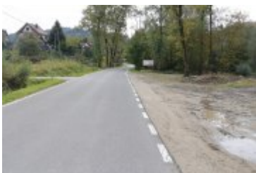
• 2022-10-06-Remont drogi w Ponicach
