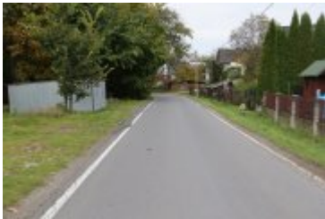
• 2022-10-06-Remont drogi w Ponicach
