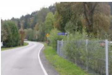
• 2022-10-06-Remont drogi w Ponicach
