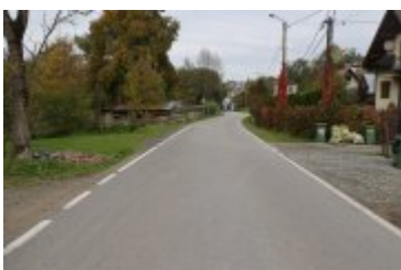
• 2022-10-06-Remont drogi w Ponicach
