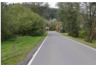
• 2022-10-06-Remont drogi w Ponicach
