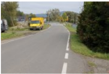
• 2022-10-06-Remont drogi w Ponicach
