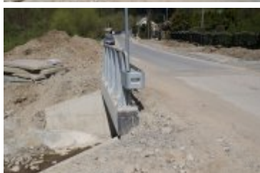
• 2023-05-10-Remont drogi powiatowej w Ponicach
