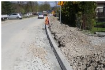
• 2023-05-10-Remont drogi powiatowej w Ponicach
