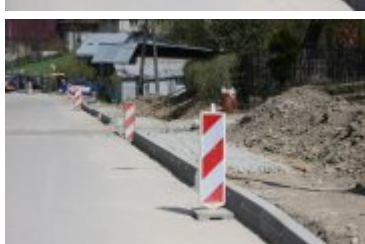
• 2023-05-10-Remont drogi powiatowej w Ponicach
