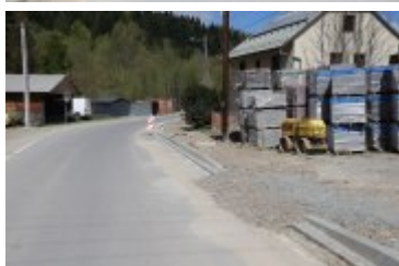
• 2023-05-10-Remont drogi powiatowej w Ponicach
