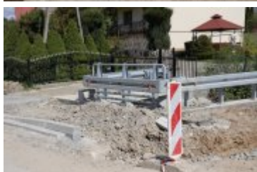
• 2023-05-10-Remont drogi powiatowej w Ponicach
