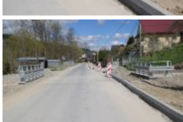
• 2023-05-10-Remont drogi powiatowej w Ponicach
