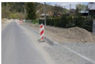
• 2023-05-10-Remont drogi powiatowej w Ponicach
