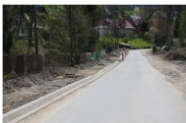
• 2023-05-10-Remont drogi powiatowej w Ponicach
