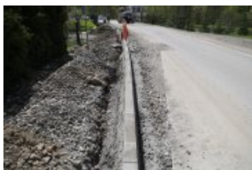
• 2023-05-10-Remont drogi powiatowej w Ponicach
