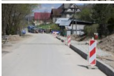
• 2023-05-10-Remont drogi powiatowej w Ponicach
