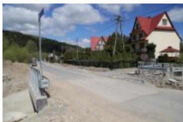
• 2023-05-10-Remont drogi powiatowej w Ponicach
