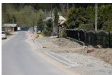
• 2023-05-10-Remont drogi powiatowej w Ponicach
