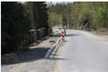
• 2023-05-10-Remont drogi powiatowej w Ponicach
