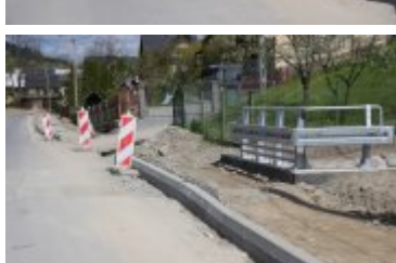
• 2023-05-10-Remont drogi powiatowej w Ponicach
