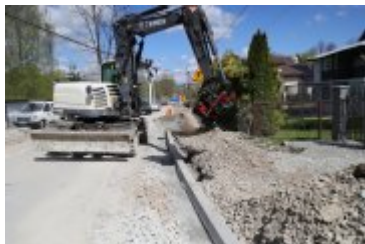
• 2023-05-10-Remont drogi powiatowej w Ponicach
