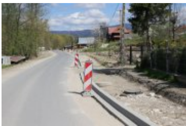
• 2023-05-10-Remont drogi powiatowej w Ponicach
