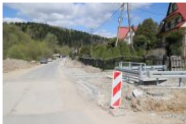
• 2023-05-10-Remont drogi powiatowej w Ponicach
