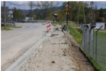
• 2023-05-10-Remont drogi powiatowej w Ponicach
