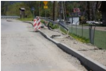
• 2023-05-10-Remont drogi powiatowej w Ponicach
