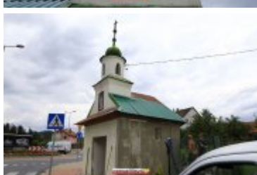
• 2017-09-12-Remont kapliczki św. Floriana przy ul. Sądeckiej
