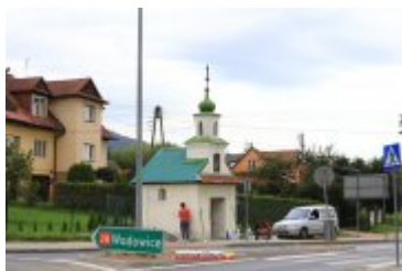
• 2017-09-12-Remont kapliczki św. Floriana przy ul. Sądeckiej
