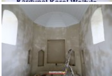
• 2017-09-12-Remont kapliczki św. Floriana przy ul. Sądeckiej
