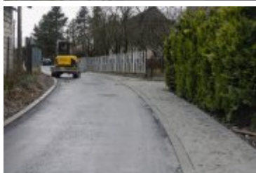
• 2024-01-03-Remont ulicy Bystrej
