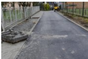
• 2024-01-03-Remont ulicy Bystrej
