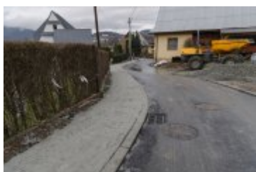
• 2024-01-03-Remont ulicy Bystrej
