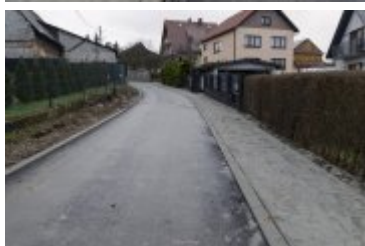
• 2024-01-03-Remont ulicy Bystrej
