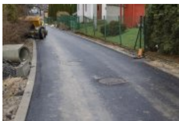
• 2024-01-03-Remont ulicy Bystrej
