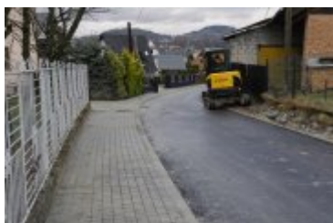
• 2024-01-03-Remont ulicy Bystrej
