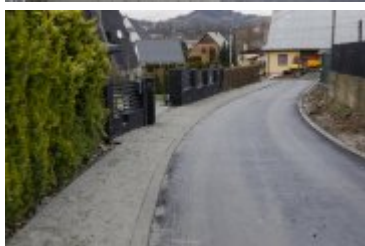
• 2024-01-03-Remont ulicy Bystrej
